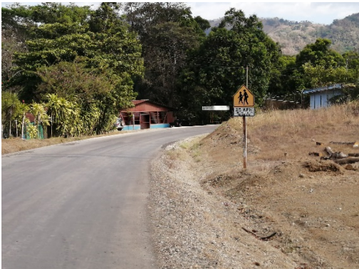
Figura N° 2. Ruta Nacional N° 163, sentido 1-2 Jicaral – San Blas
