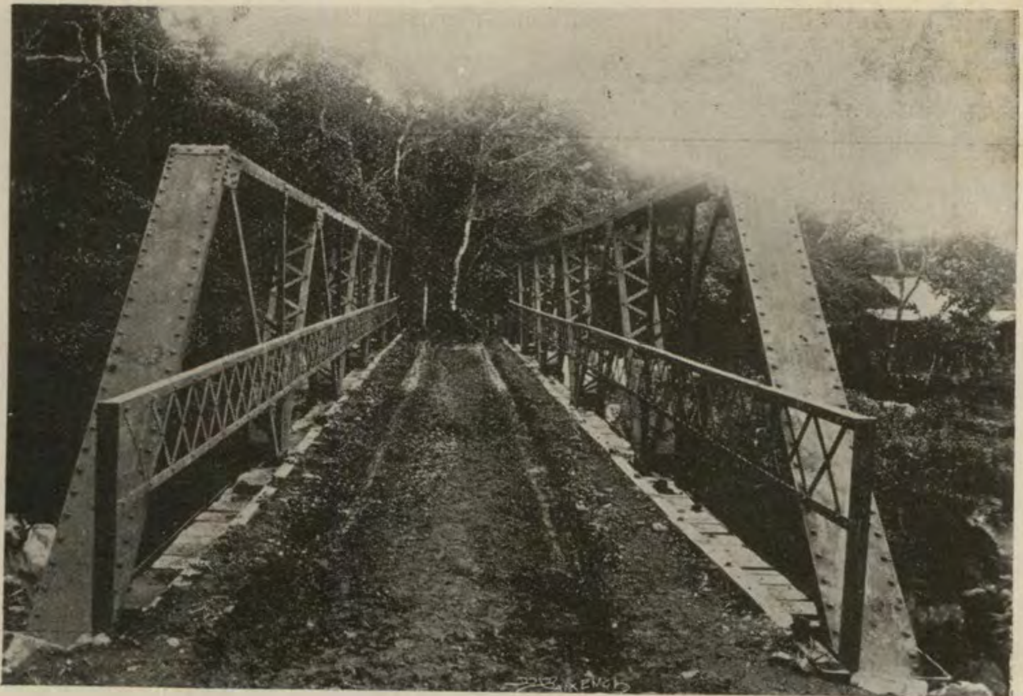
Fraijanes (Alajuela). Puente sobre el río Poás
