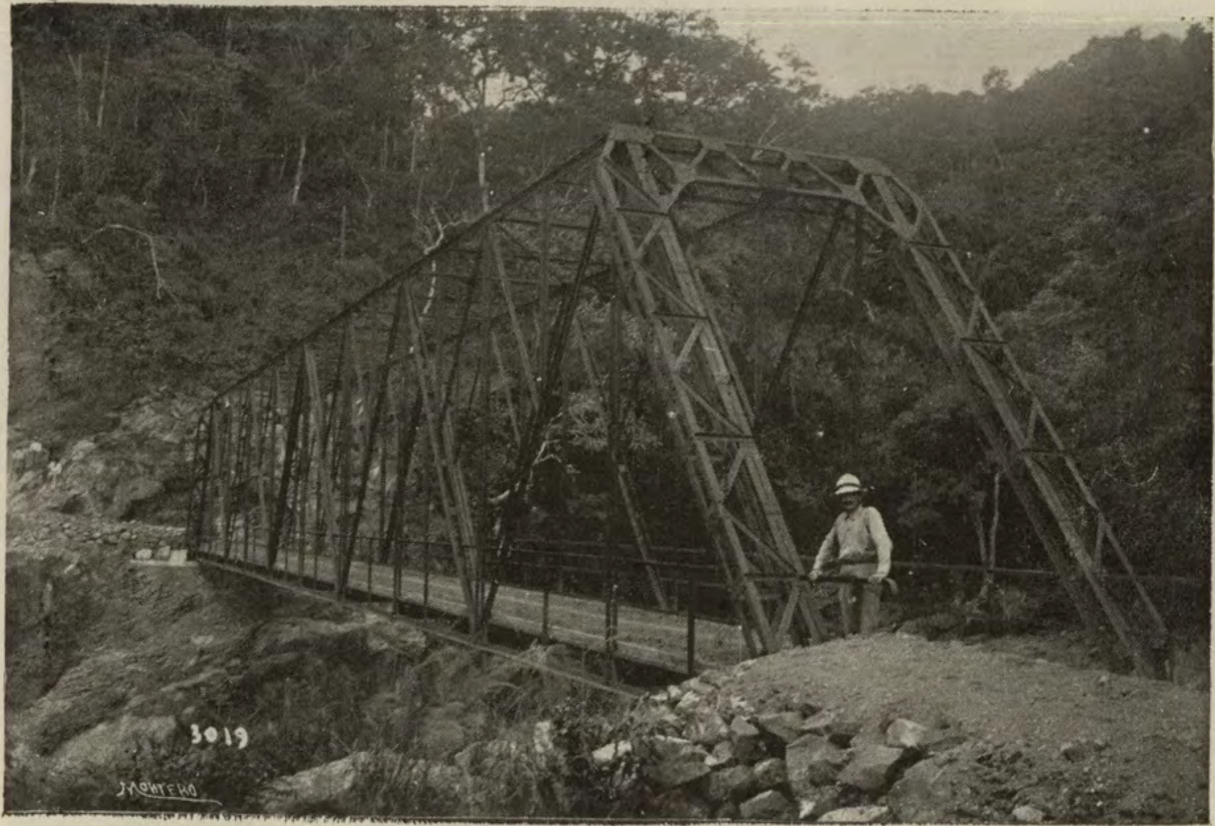
PUENTE SOBRE EL RIO LA Balsa
