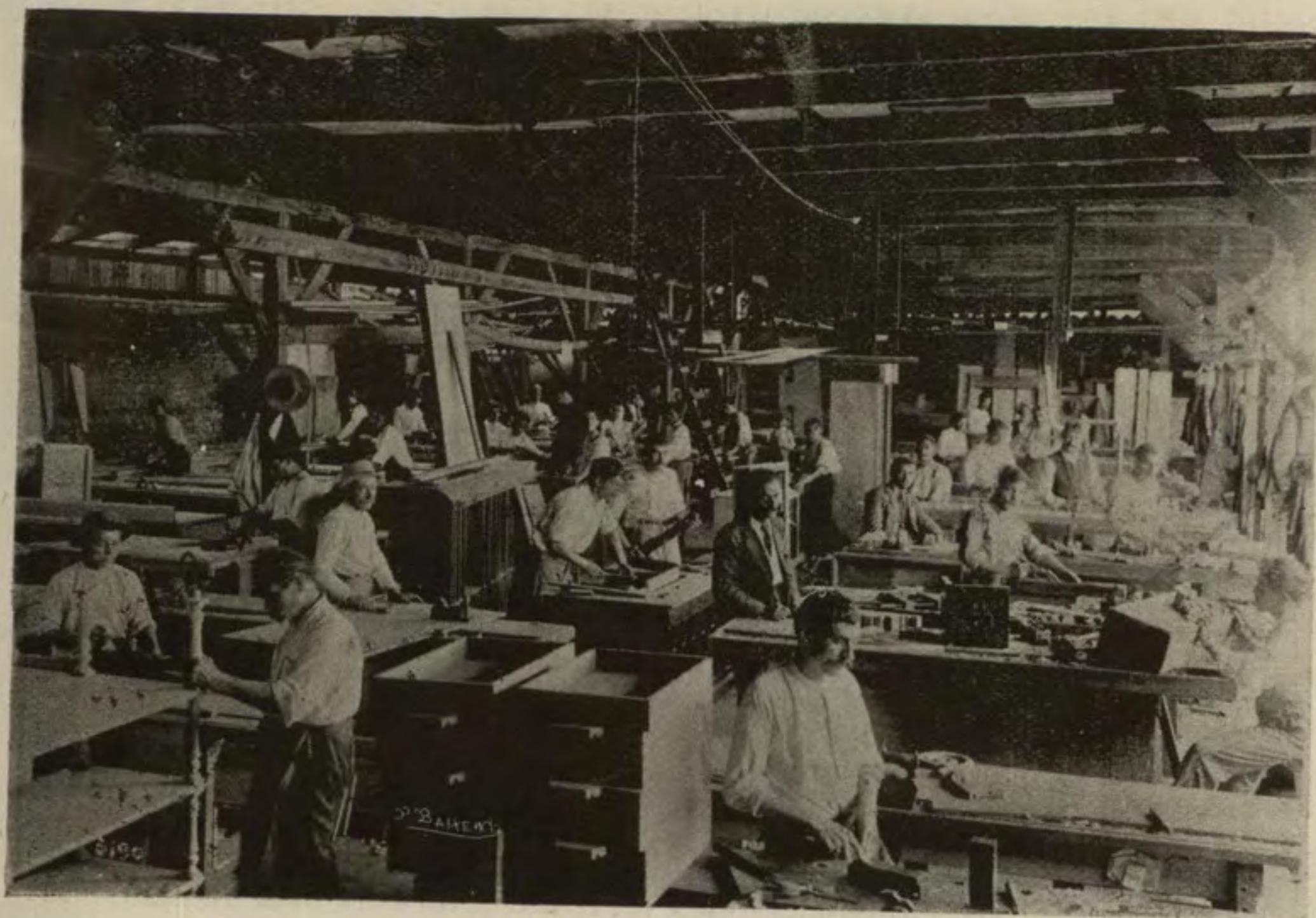
Taller de Obras Públicas. Carpintería
