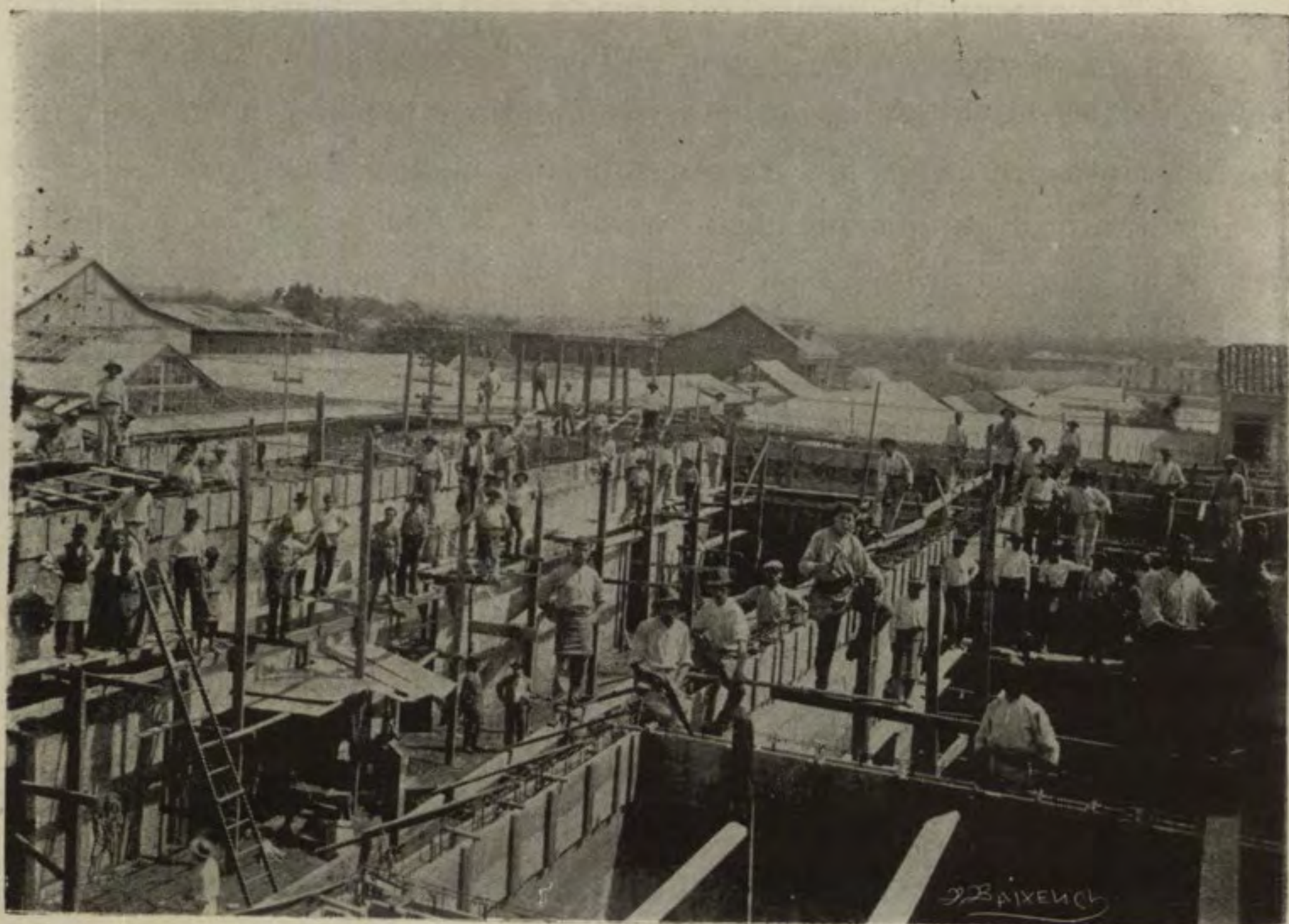
Interior de la Imprenta Nacional en construcción
