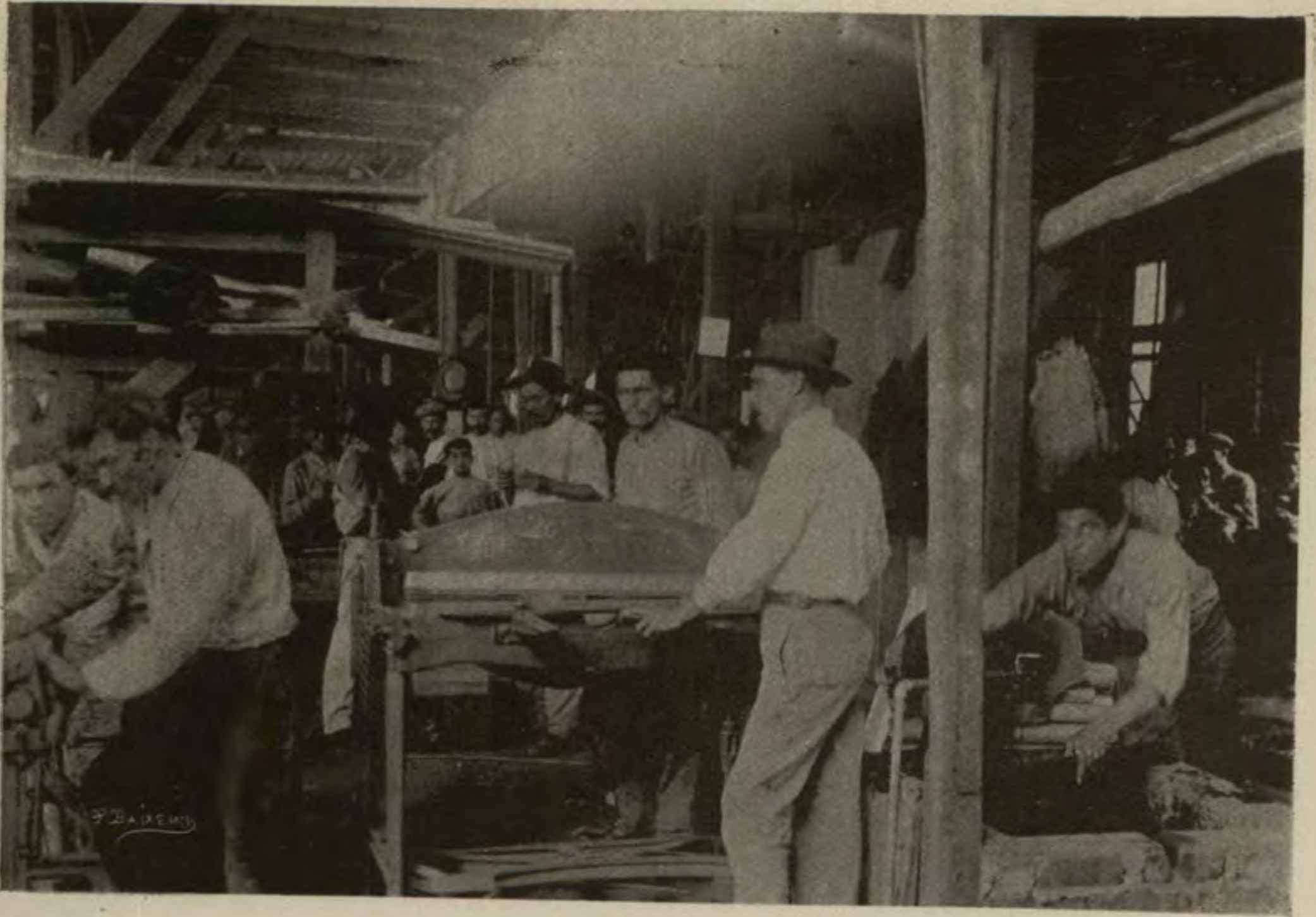
Taller de Obras Públicas. Hojalatería
