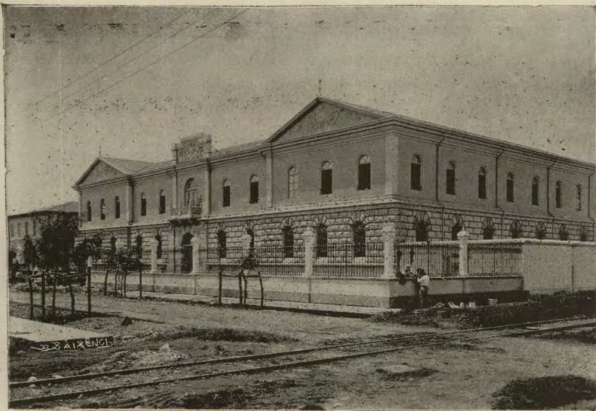
Liceo de Costa Rica. Edificio del Este
