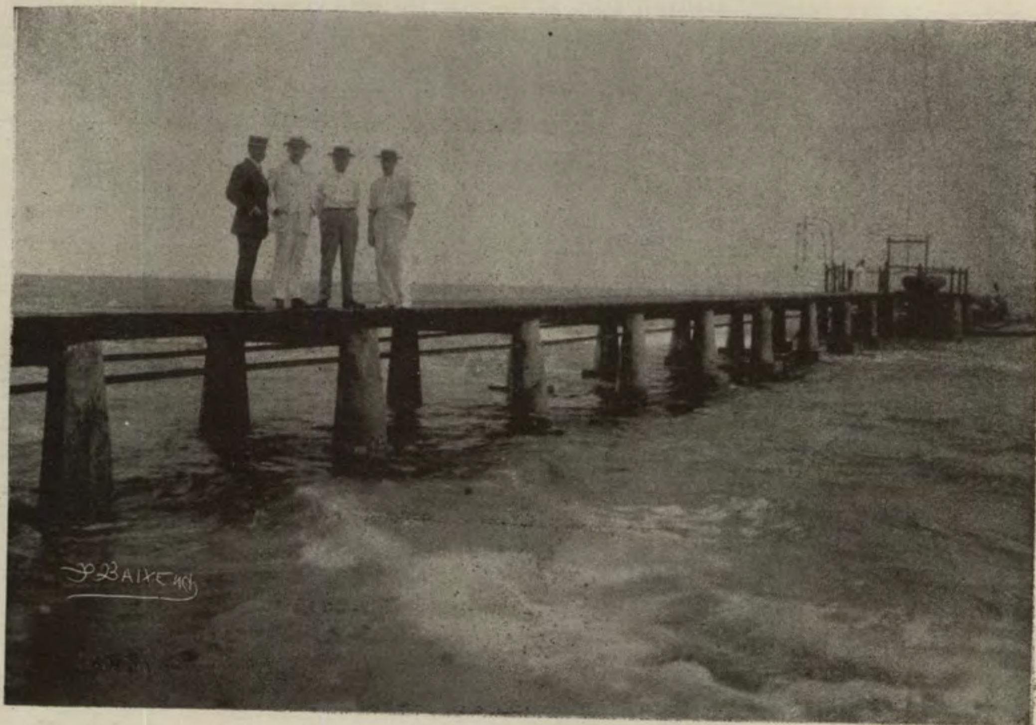
Ciudad de Limón. Muelle nuevo de cemento armado de la isla "La Uvita"
