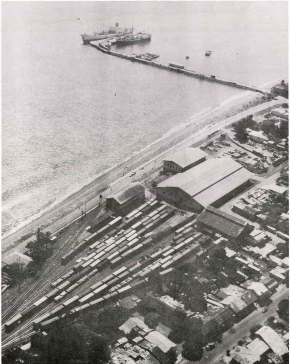
Vista aérea del patio de Ferrocarril y muelle principal de Puntarenas.
