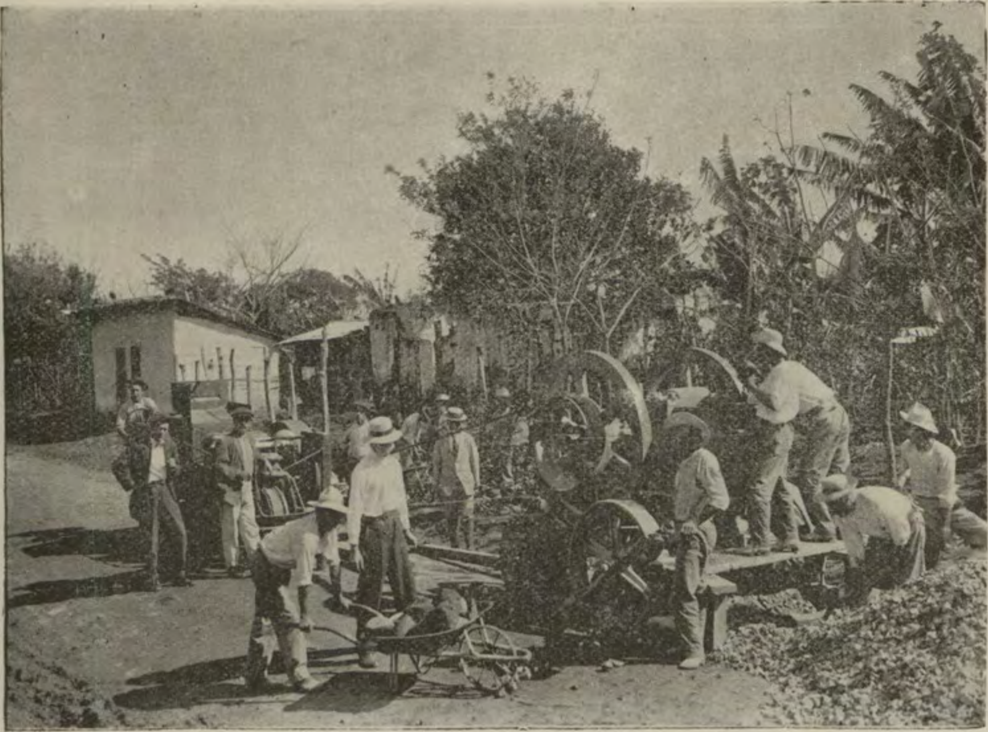
Carretera nacional a Alajuela y Heredia (Quebrador de piedra movido por un tractor de gasolina)
