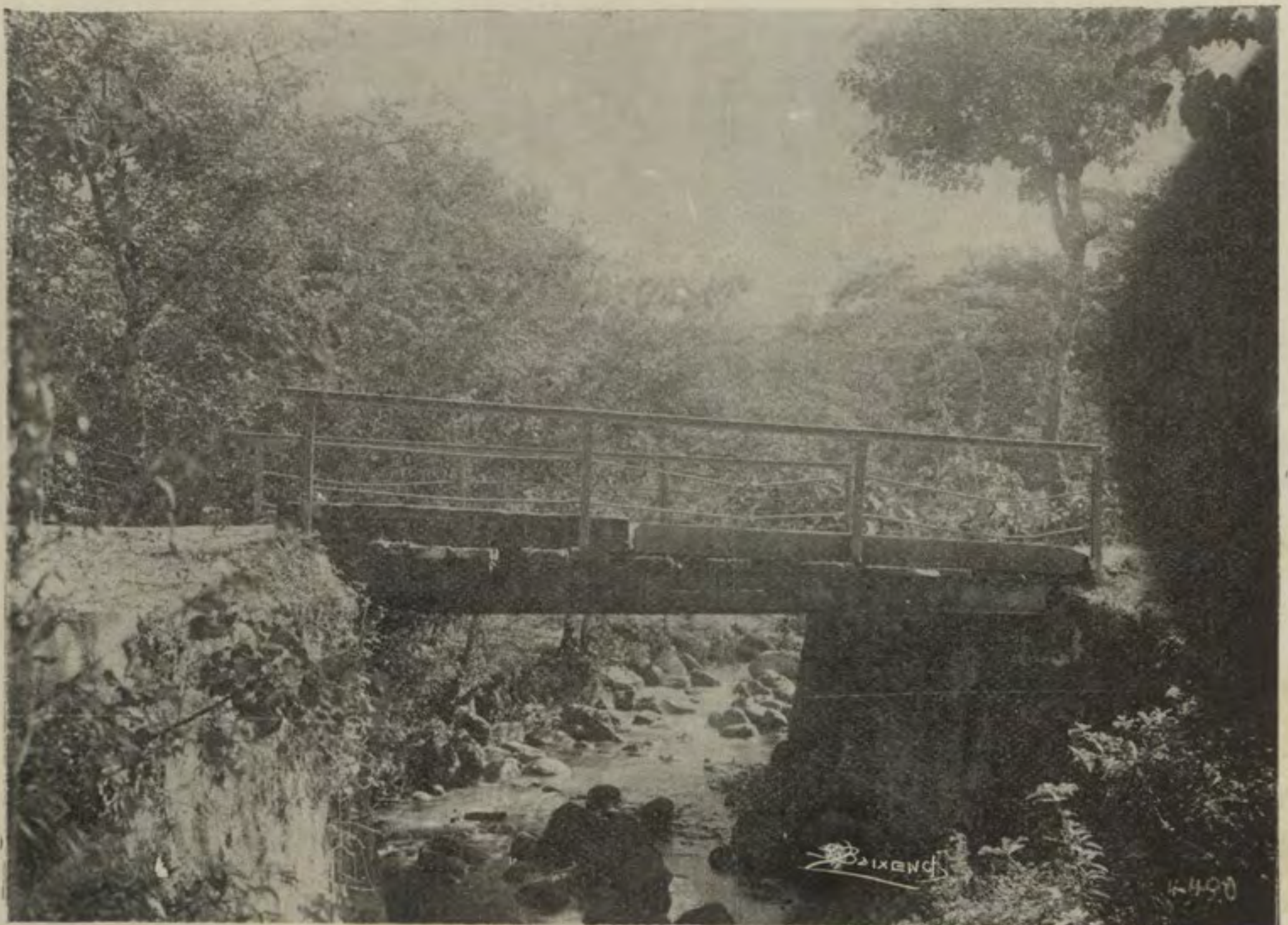
Puente sobre el río Chiquito, carretera a Cartago
