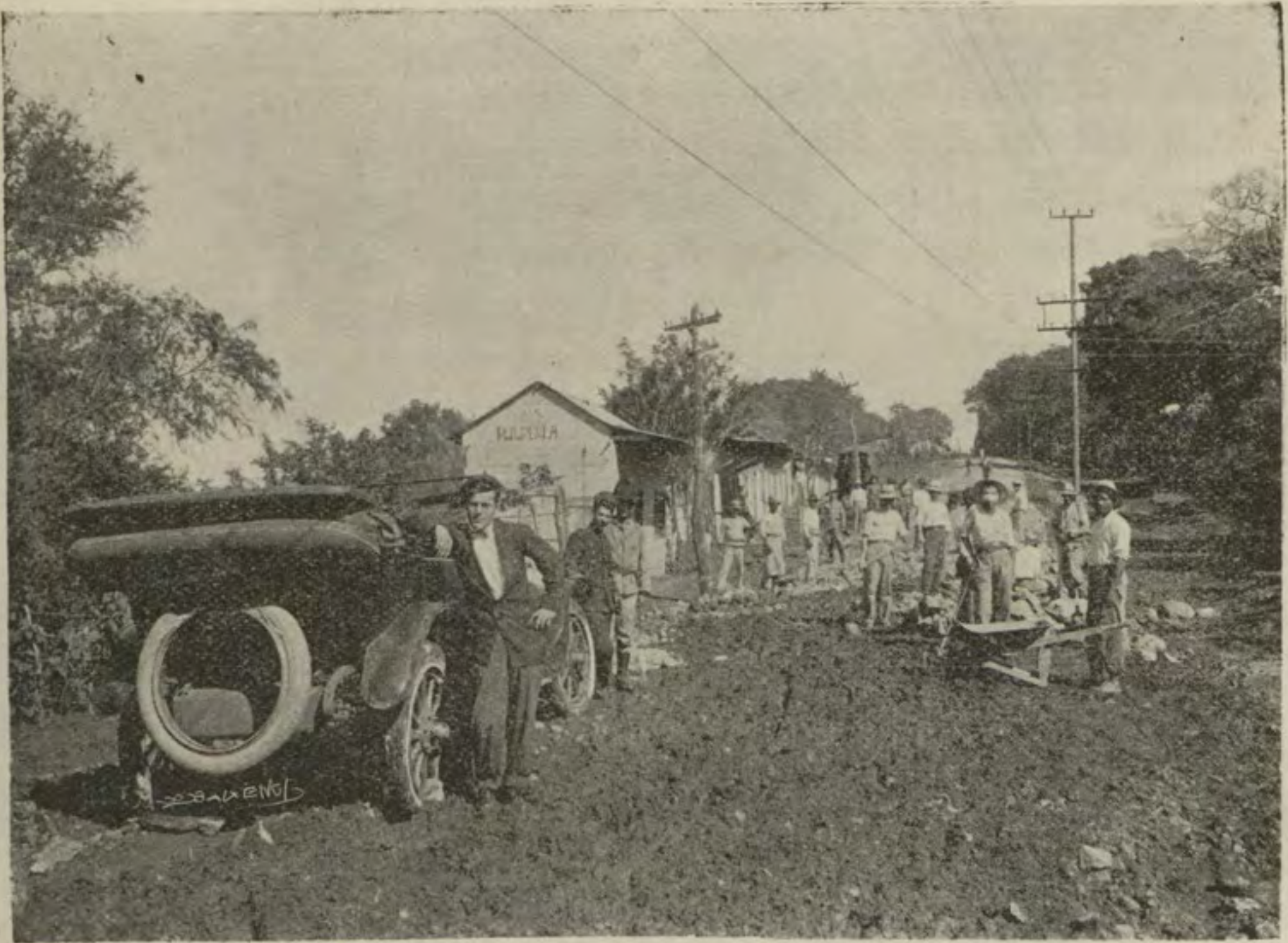
Carretera nacional a Alajuela y Heredia. - Cuadrilla de reos trabajando en este trayecto
