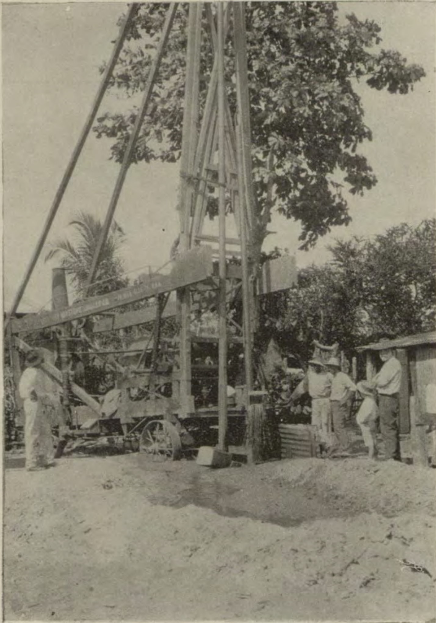
Máquina perforadora de pozos artesianos en Puntarenas Capacidad, 1000 pies — 304 metros
