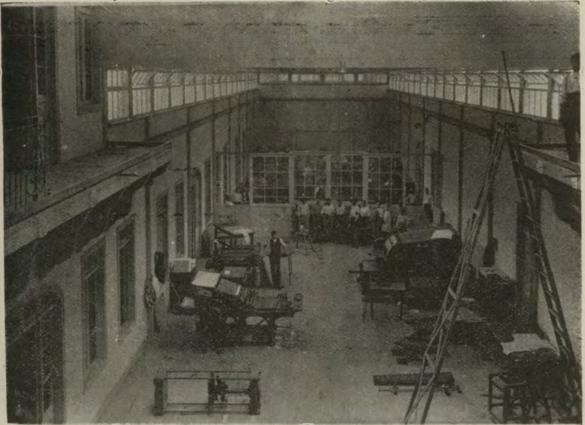
Imprenta Nacional. Vista del salón central
