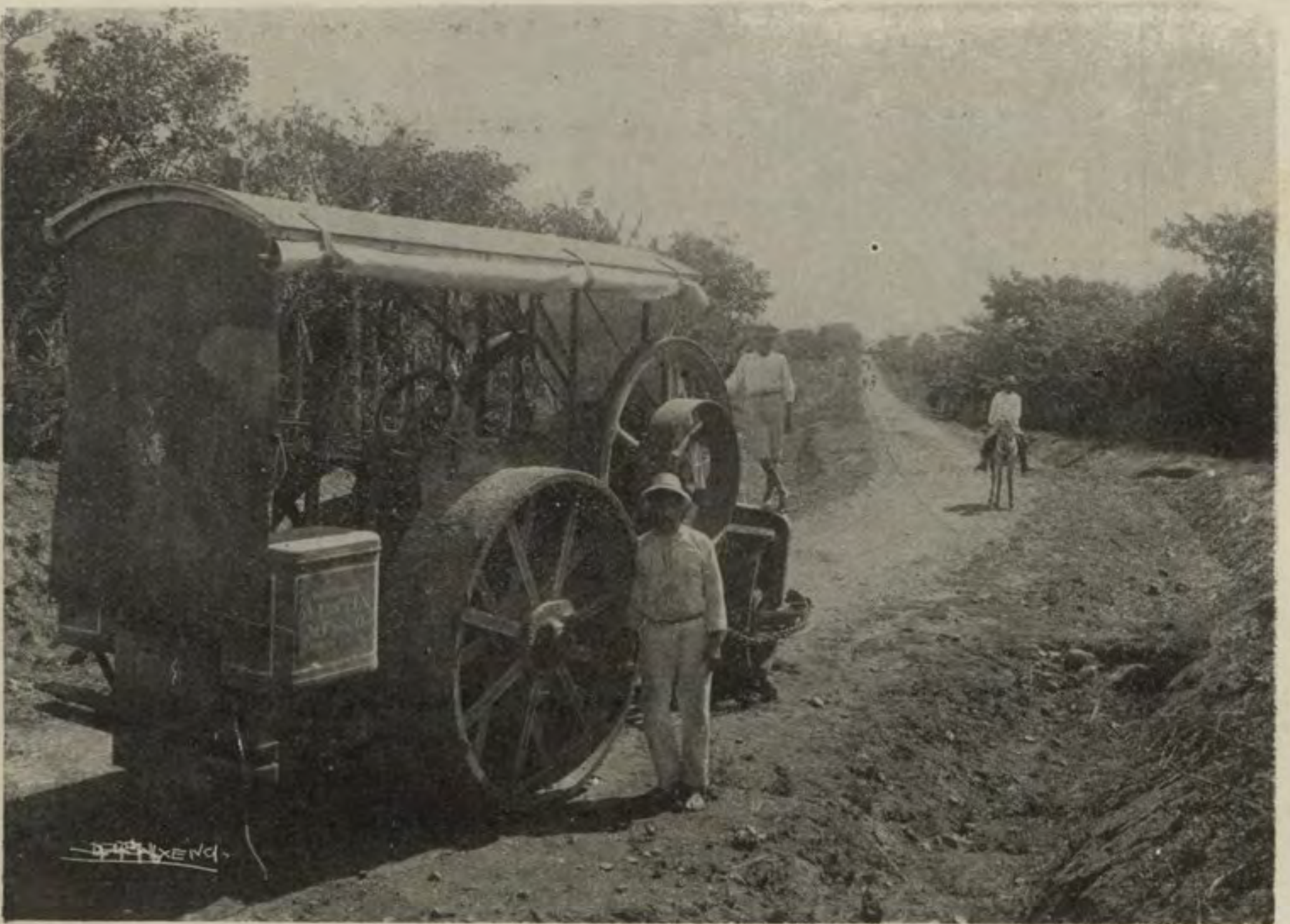
Camino de La Pitahaya, Cartago. Aplanadora de gasolina
