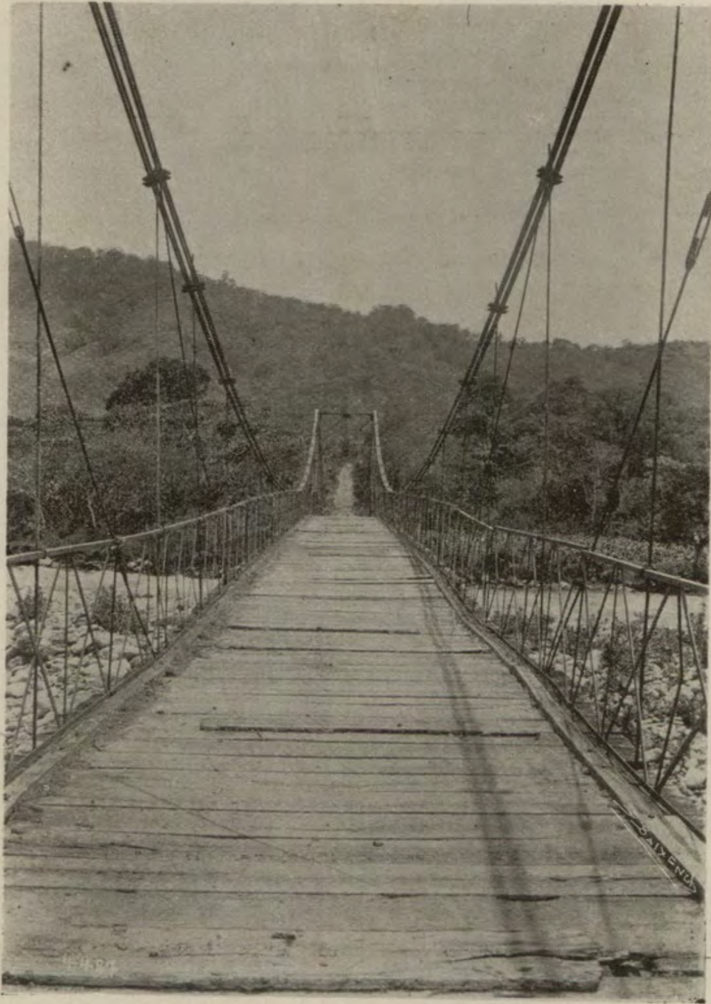
Puente de Palomo, Paraíso. Reconstruido en 1915
