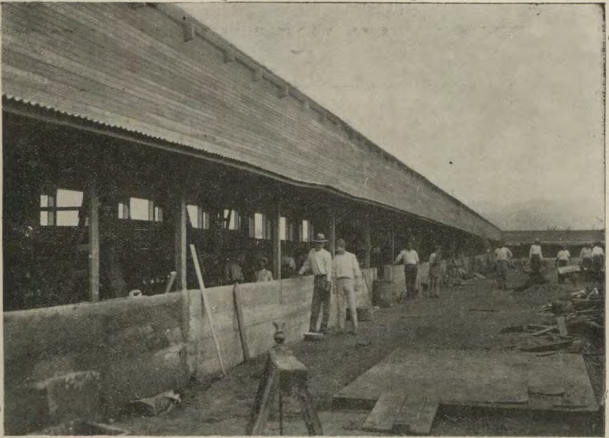
Escuela de Artes y Oficios. Departamento de cementación (en construcción)
