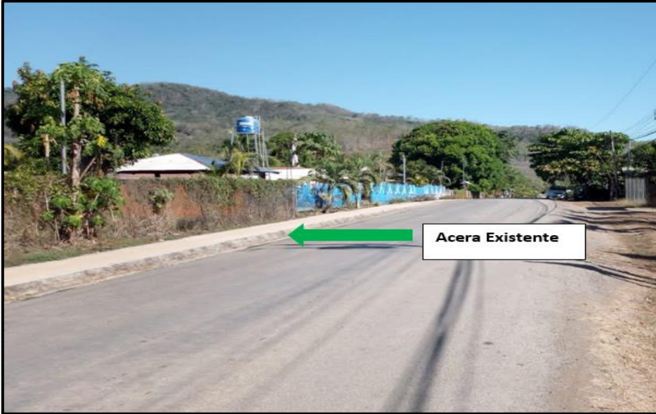
Imagen N° 3. Acera existente a un costado de la vía.
