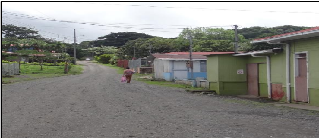
Imagen N° 4. Calle en lastre, vía cantonal.
