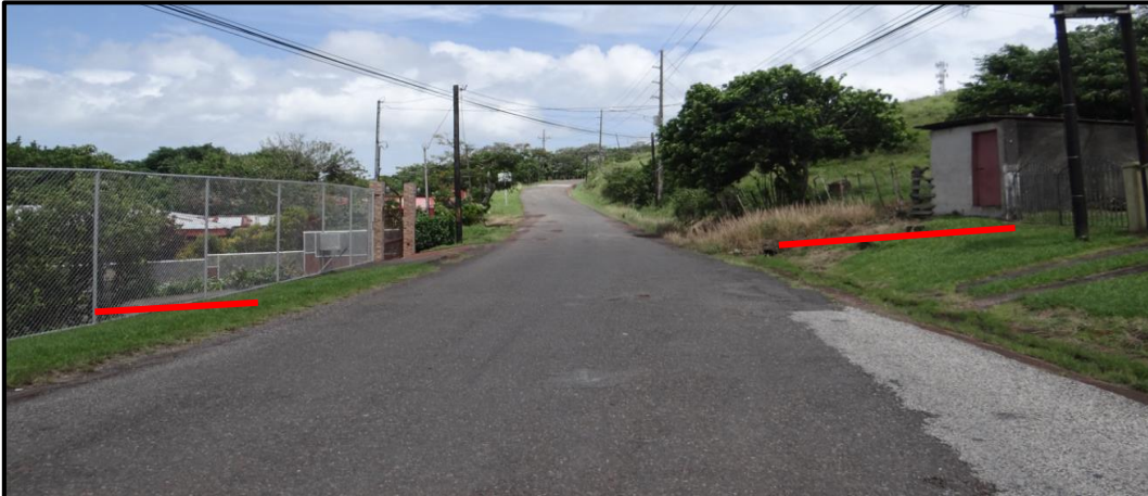
Imagen N° 3. Falta de aceras (línea roja).
