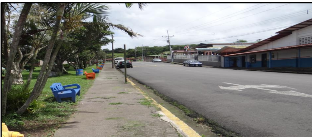
Imagen N° 4. Carpeta asfáltica, vía cantonal.
