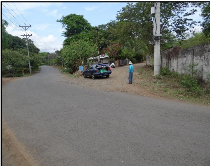
Imagen N° 4. Falta de acera.
