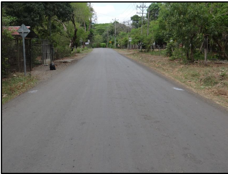
Imagen N° 2. Tratamiento superficial Ruta Nacional N° 911.
