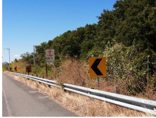
Figura N° 3. Señalamiento vertical inmediaciones del puente La Amistad.
