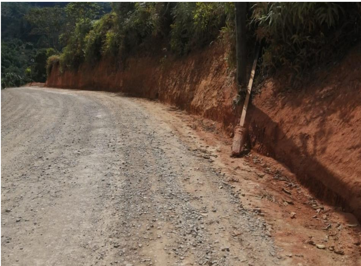
Figura 5. Tramo Ruta Nacional N° 325, sentido hacia San Ramón Norte
