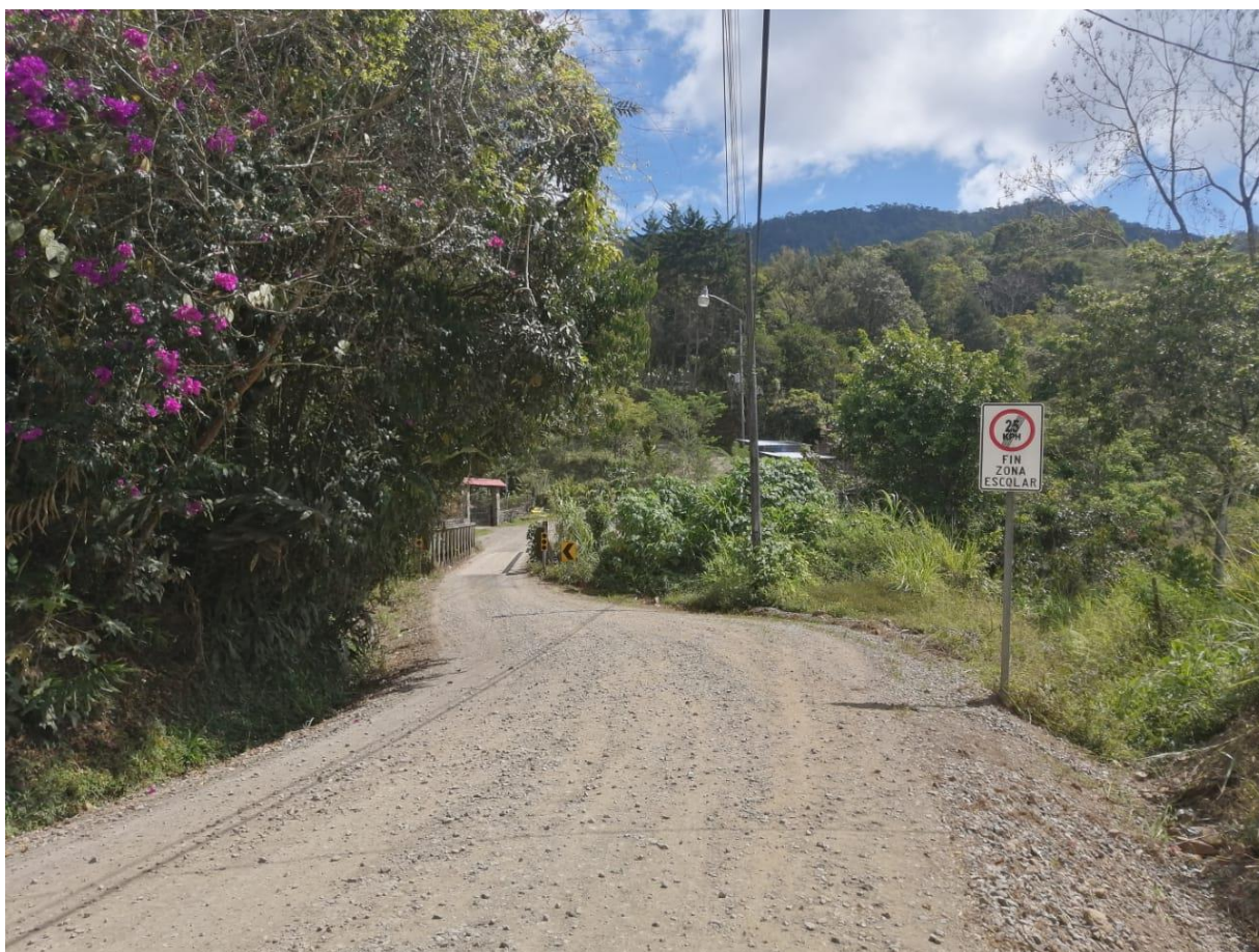
Figura 4. Tramo Ruta Nacional N° 325, sentido hacia La Ese
