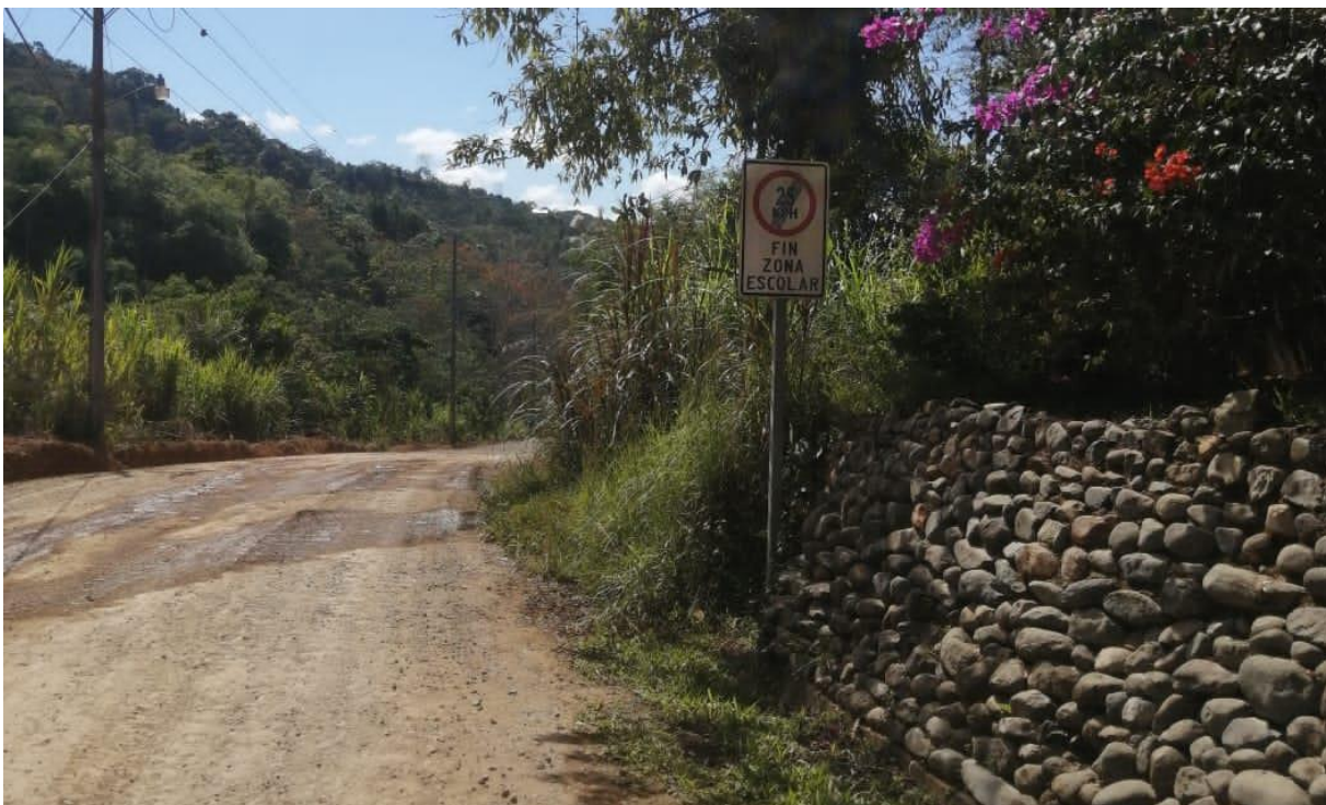
Figura 2. Tramo Ruta Nacional N° 335, sentido hacia Santa Eduvigis
