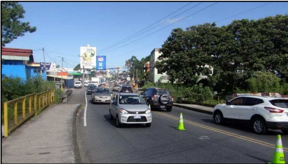
Imagen N° 664 Funcionalidad en el puente sobre Río María Aguilar, dos carriles uno por sentido de circulación
