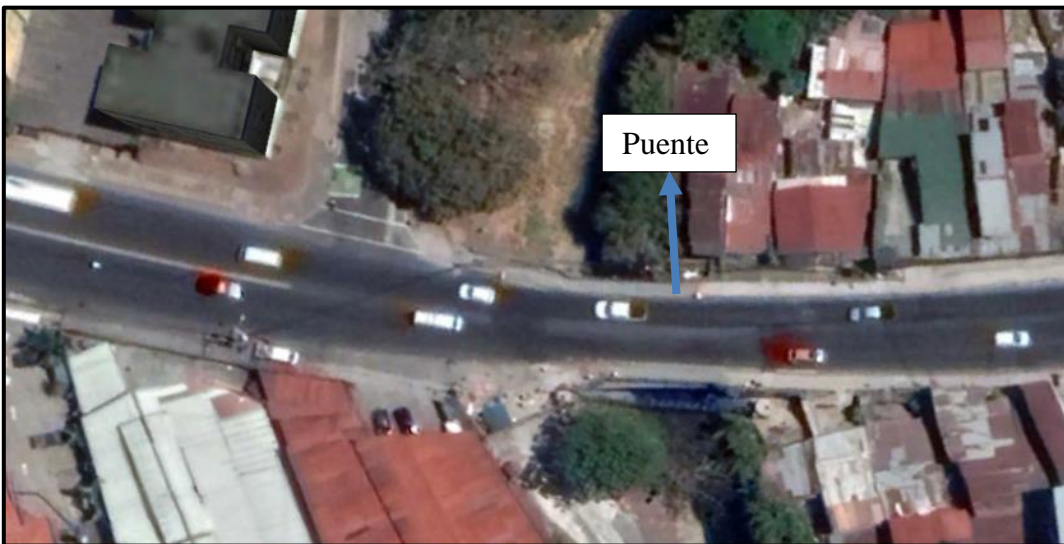
Imagen N° 65 Funcionalidad en el puente sobre Río María Aguilar, dos carriles uno por sentido de circulación
