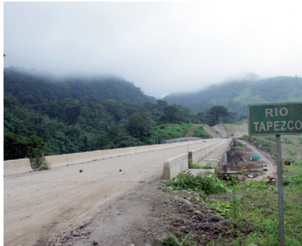
7 puentes están concluidos y 3 presentan un importante avance
