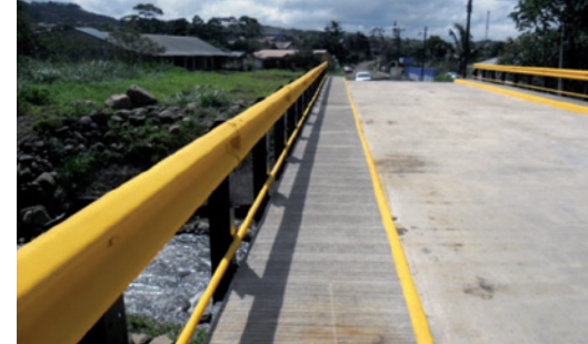
Construcción de puente sobre Río Fortuna, San Carlos
