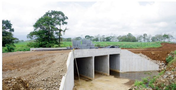
Los 20 pasos de alcantarillas que posee el proyecto ya han sido concluidos.
