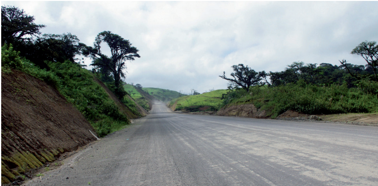
El 79.93% de la ruta se encuentra listo para colocar pavimento asfáltico.
