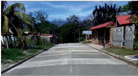
Construcción de losa de concreto, Calle Verolis, Esparza
