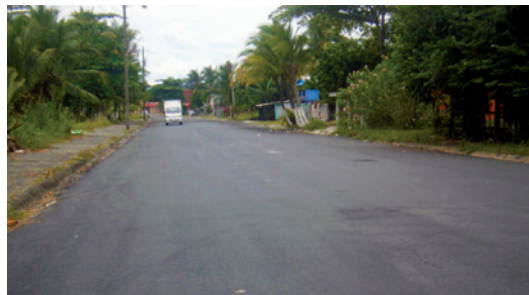
Recubrimiento asfáltico, cuadrantes Puerto Viejo, Limón
