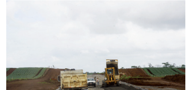
Se avanza en la colocación de capa estructural en los 8km.
