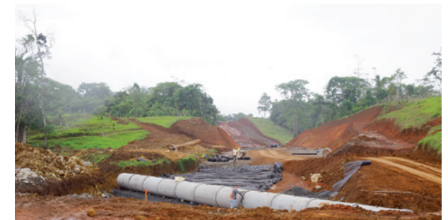
Los obras de drenaje cuentan con un 97% de avance.
