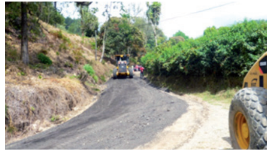
Rivas-San Gerardo, Pérez Zeledón, conformación de superficie y limpieza de cunetas, espaldones y derecho de vía en 9,4km
