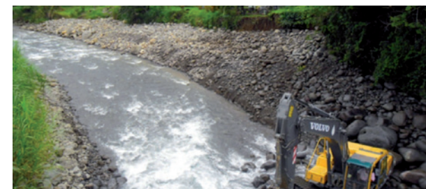
Canalización y Obras de Protección Marginal Río Caño Grande, Venecia de San Carlos
