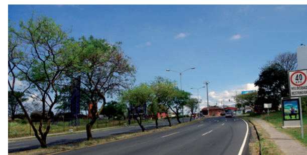
Recarpeteo de la parte de la RN 39, Circunvalación.
