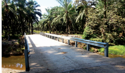
Construcción de puente sobre el río Damas en Parrita
