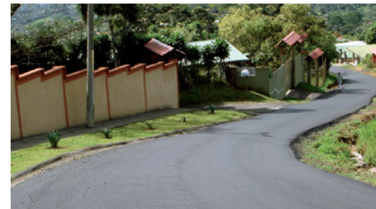
Colocación de carpeta asfáltica, ruta La Eva San Juan-Plaza La Luisa, Valverde Vega
