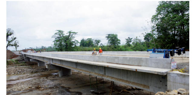
Puente sobre el río Toro, 115,5m de longitud, concluido.
