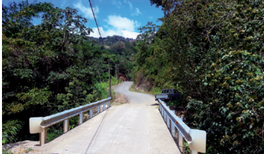
Construcción de puente sobre Quebrada Honda, Montes de Oro
