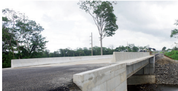
Se completó la construcción del puente sobre el río Pericos.
