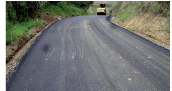
Higuito, San Isidro – La Cangreja, colocación de carpeta asfáltica
