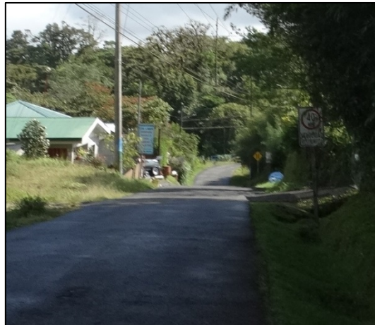
Figura N° 5. Señalamiento Vertical existente
