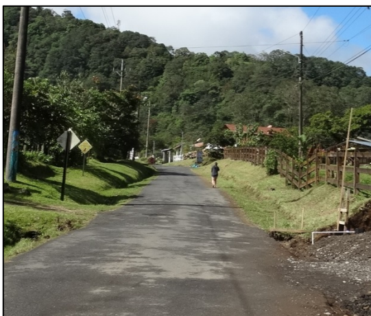
Figura N° 6. Peatones por la calzada
