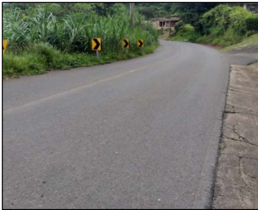
Figura 17. RN N°705, señales chevron y cuneta
