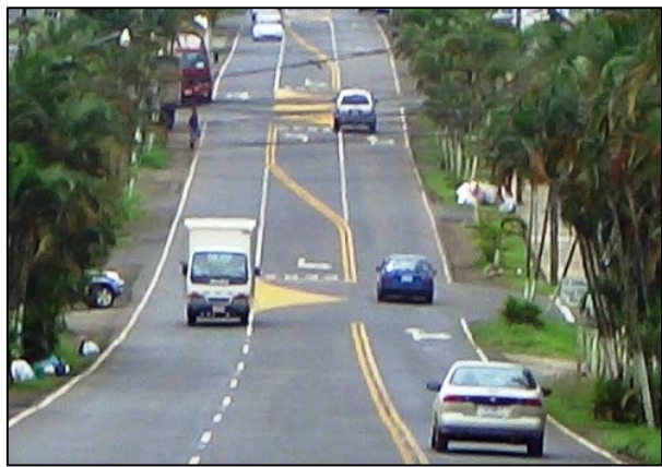
Figura 3. Tramo RN 135 con carriles de giro
