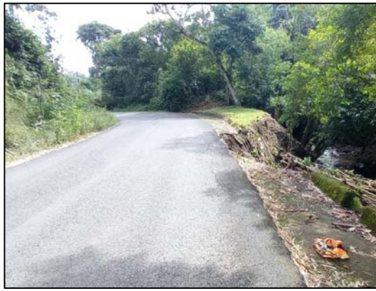
Figura 18. RN N°714, Margen con cuneta y áreas verdes
