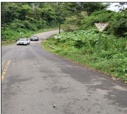
Figura 11. RN N702 sector montañoso, señal vertical
