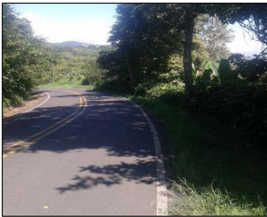
Figura 2. RN 135, márgenes en zona verde, calle sin baches
