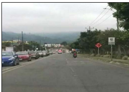
Figura 14. RN 156 aceras, señalamiento 40 km/h
