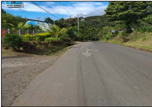
Figura 15. RN 742, márgenes en verde, carpeta sin grietas
