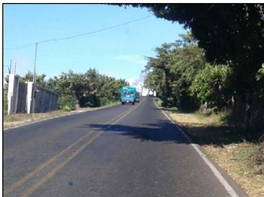
Figura 6. RN 141, doble línea centro y bordes, zona verde
