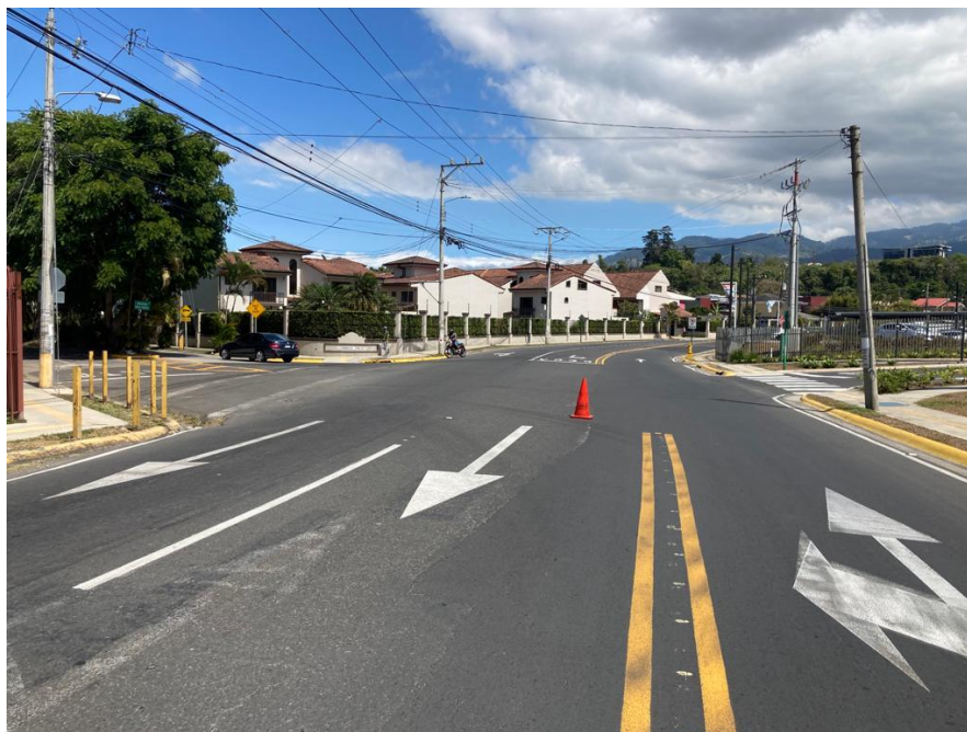
Figura 7. Demarcación horizontal. Fuente: Propia, 2022.
