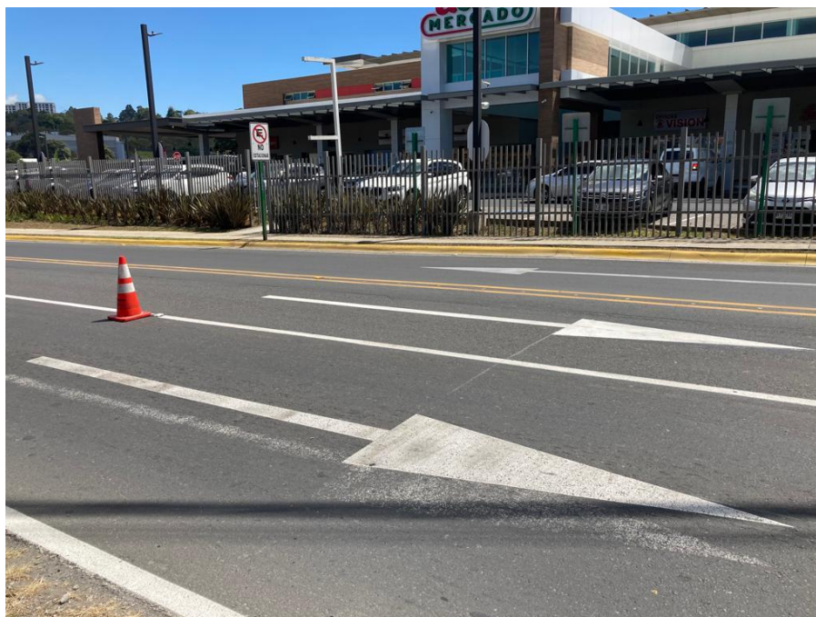
Figura 8. Demarcación horizontal. Fuente: Propia, 2022.
