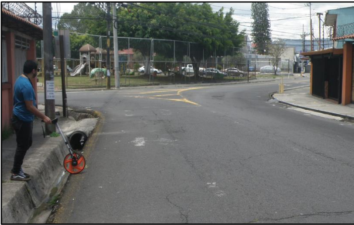
Figura 4 Intersección de Calle 61 A y Ruta de Travesía N°11807, condiciones del señalamiento vial.
