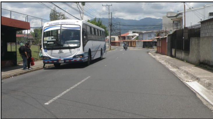
Figura 5 Ruta de Travesía N°11807, condiciones del señalamiento vial, vista Norte-Sur.
