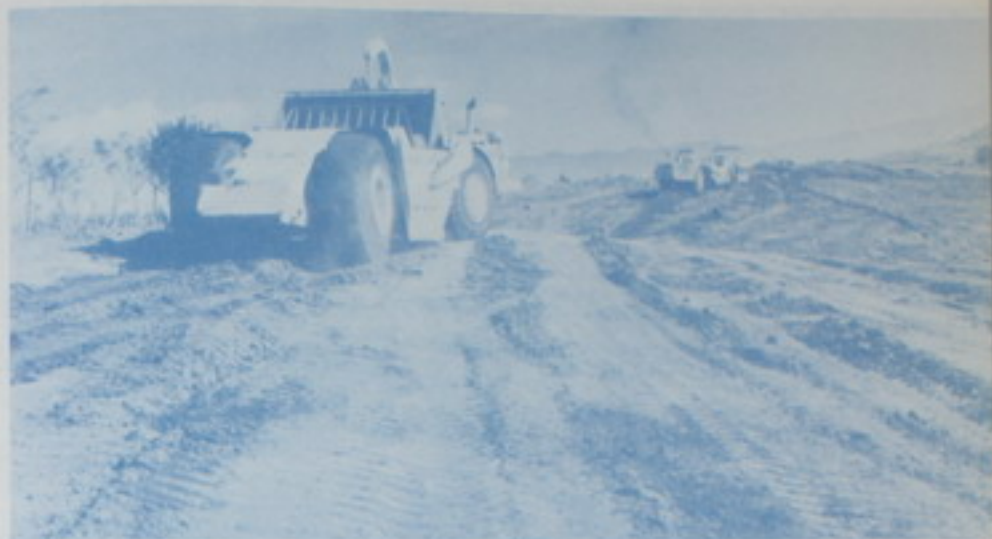
AUTOPISTA EL COCO-SAN RAMON: Actualmente están en ejecución 35 Km., habiéndose firmado contratos por valor de 57 millones de colones .
