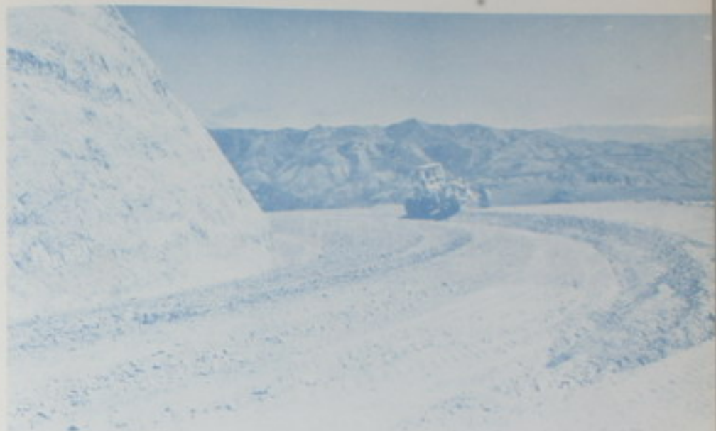
CRIFO ALTO-SAN PABLO DE TURRUBARES: Importante cambio vecinal con una longitud de 10,40 Km. La vía permitirá salida a una población que ha estado aislada hace muchos años .
