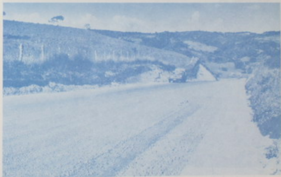
CARRETERA CAÑAS-TILARAN: Una moderna vía de 22,80 Km. ha dejado unidos a estos dos cantones de la Provincia de Guayas.
