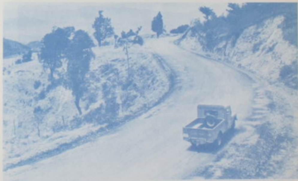
DESAMPARADOS-ACOSTA : Finalizaron los trabajos de construcción de esta moderna carretera, la que tiene una longitud de 22,58 Km.
