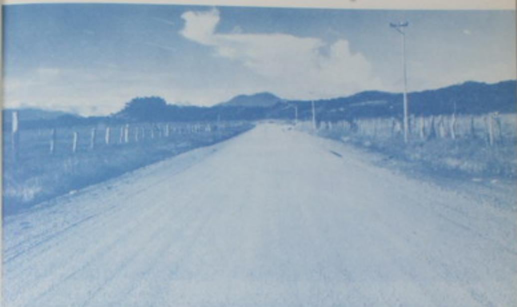
SAN PABLO-CANJEL: Ha quedado totalmente terminada la construcción de este proyecto vial, el cual tiene una longitud de de 9,5 kilómetros.
