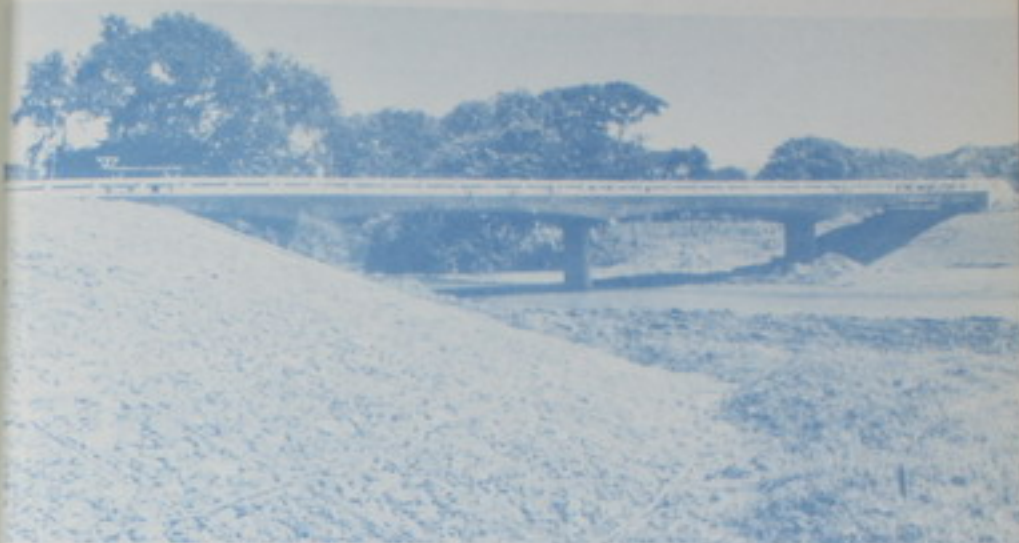
PUENTE RIO ENMEDIO : Esta estructura con una longitud de 66,5 metros y un costo de Q825,100, fue construida en la carretera Santa Cruz-Nicoya.
