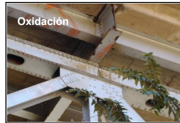
Descascaramiento de pintura
