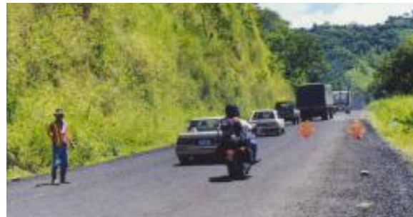
Foto 8.2.1. Ejemplo de Control de tráfico con banderas en un Proyecto de reconstrucción de la carretera
