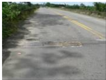
(a) Junta de Expansión Rota
