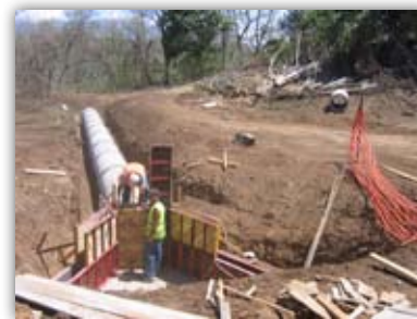
Trabajos de colocación de tuberías
