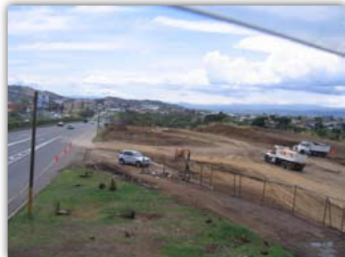
Trabajos preliminares a la altura del peaje Escazú
