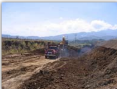
Movimiento de tierras en tramo Ciudad Colón-Orotina
