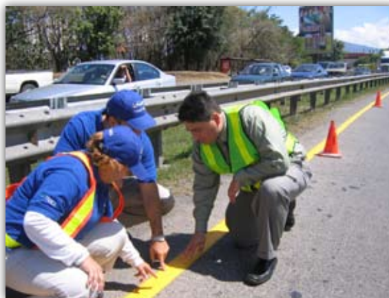
Trabajos de demarcación inicio de la ruta 32
