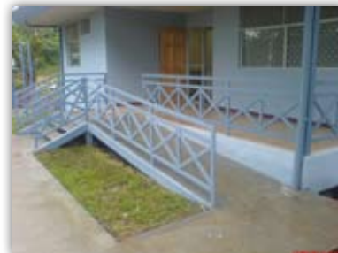
Nuevas instalaciones Capitanía Los Chiles Moín.
