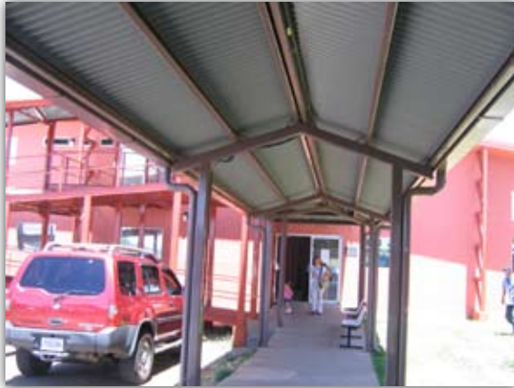
Entrada principal del nuevo edificio de Licencias
