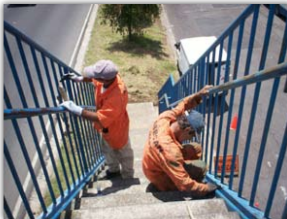
Mejoras en puente peatonal Hatillo 8
