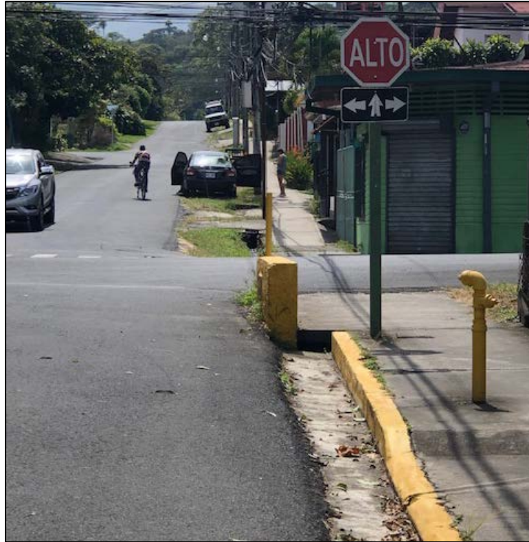
Figura 47. Asfalto en buen estado, señal vertical de alto.
