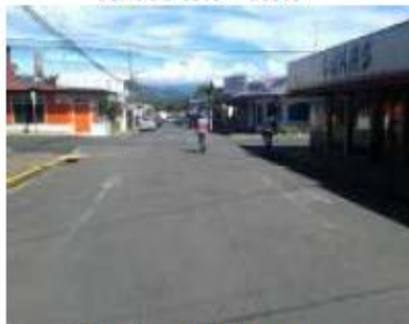
Costado este del Parque sentido sur – norte
