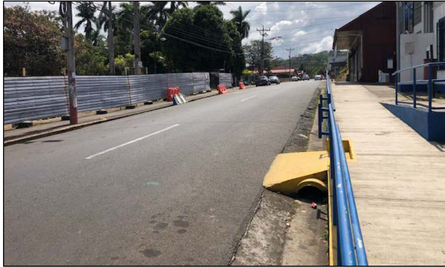
Figura 16. Cordón amarillo frente al edificio municipal.
