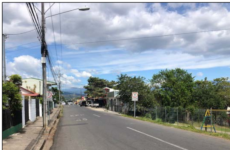
Figura 9. Sector sin restricción de estacionamiento y acera solo en un costado
