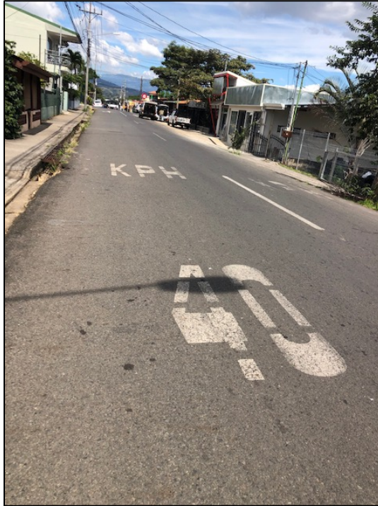
Figura 6. Carpeta sin grietas ni exposición de agregado grueso, un sentido.
