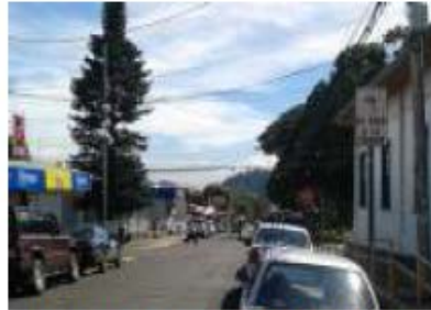
Esquina noreste de la Municipalidad sentido oeste – este
