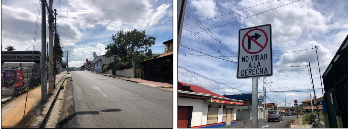
Figura 18. Demarcación horizontal borrosa y vertical.
