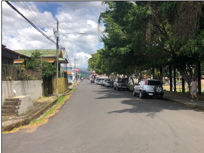
Figura 22. Tramo sin demarcación, con aceras incompletas.
