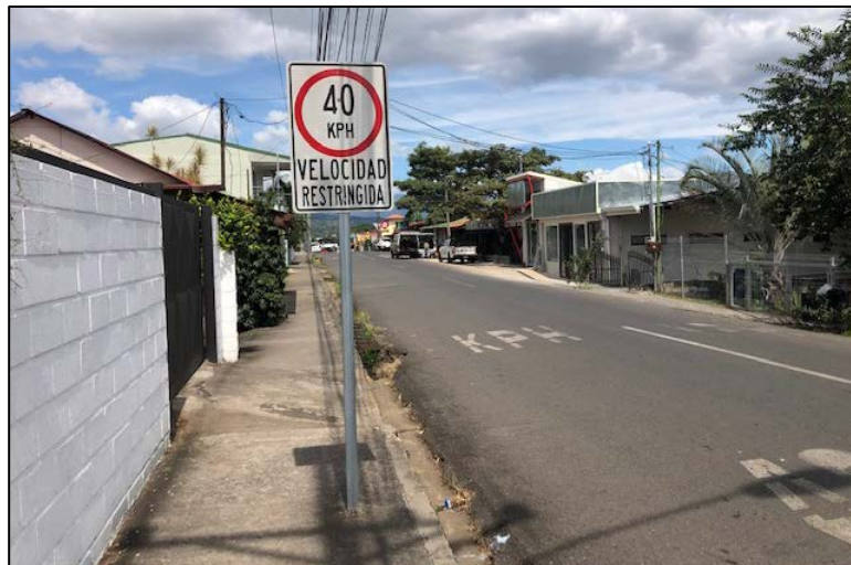
Figura 7. Señalamiento vertical, aceras en ambos costados
