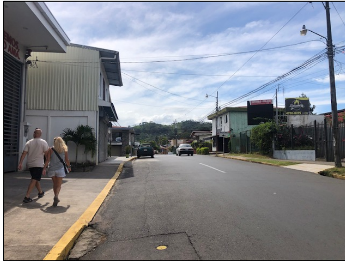
Figura 26. Cordón amarillo al costado oeste, dos carriles en un solo sentido.
