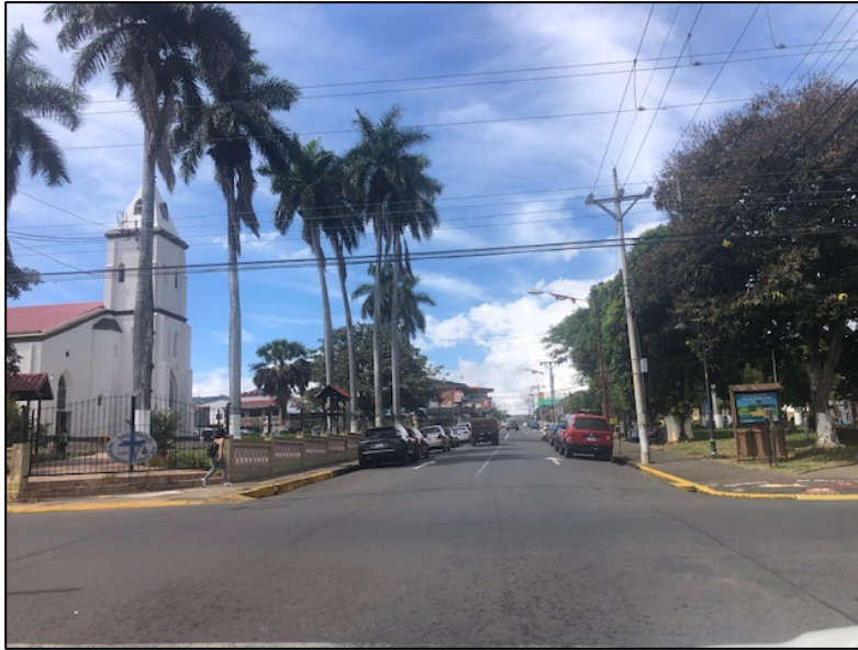
Figura 43. Carpeta sin grietas ni agregado grueso expuesto, aceras en ambos lados.
