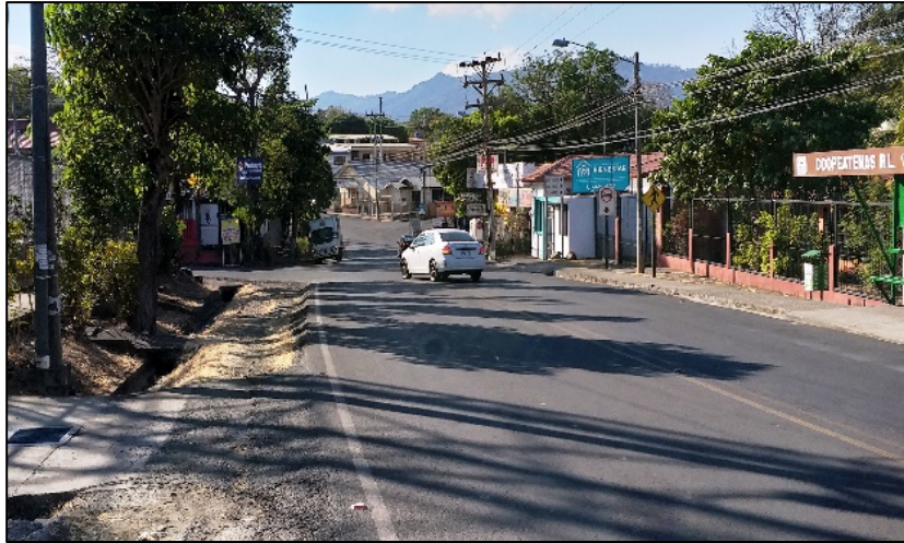
Figura 30. Señalamiento horizontal borroso, acera a un costado y parada de autobús
