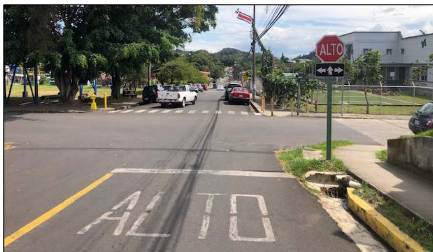
Figura 55. Carpeta sin grietas, aceras en ambos lados, horizontal borroso
