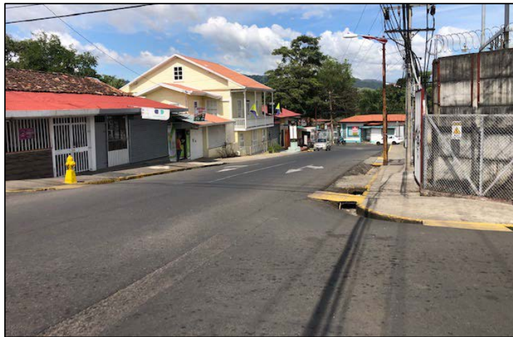
Figura 19. Calle 0 con un solo sentido de vía, demarcación de líneas y figuras.
