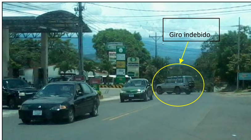
Figura 32. Señalamiento horizontal borroso, doble sentido circulación y la estación de servicio.
