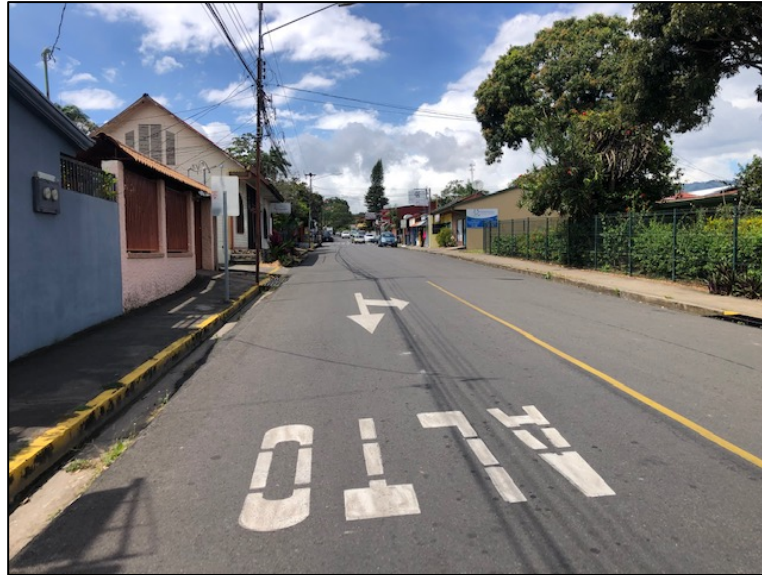
Figura 39. Carpeta y señalamiento horizontal en buen estado, aceras en ambos lados
