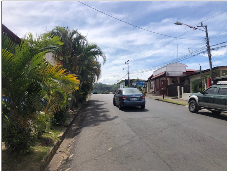
Figura 28. Carpeta asfáltica sin grietas ni agregado grueso expuesto, aceras en ambos costados.
