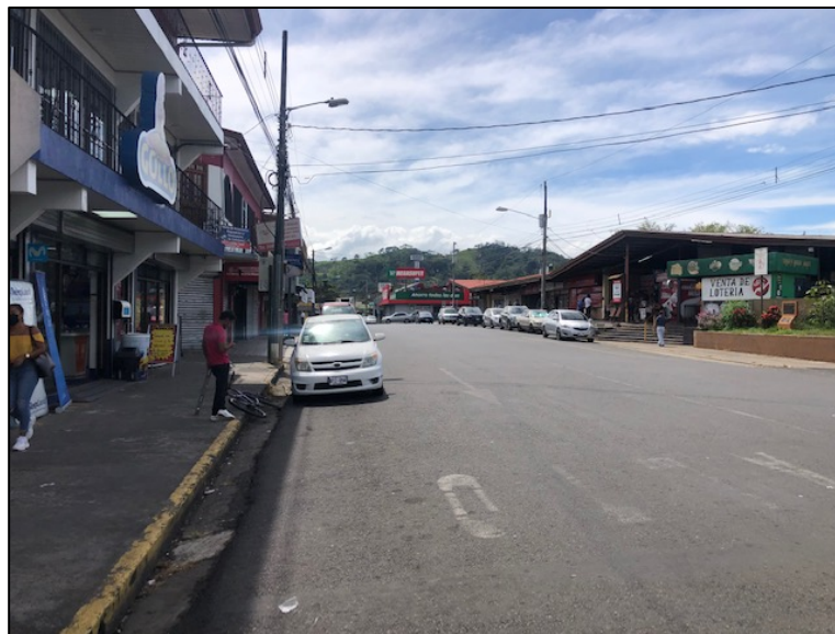
Figura 44. Carpeta sin grietas ni material grueso expuesto, señalamiento horizontal borroso
