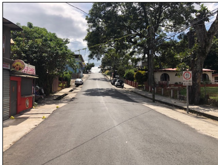
Figura 24. Señalamiento vertical, y ausencia de horizontal.
