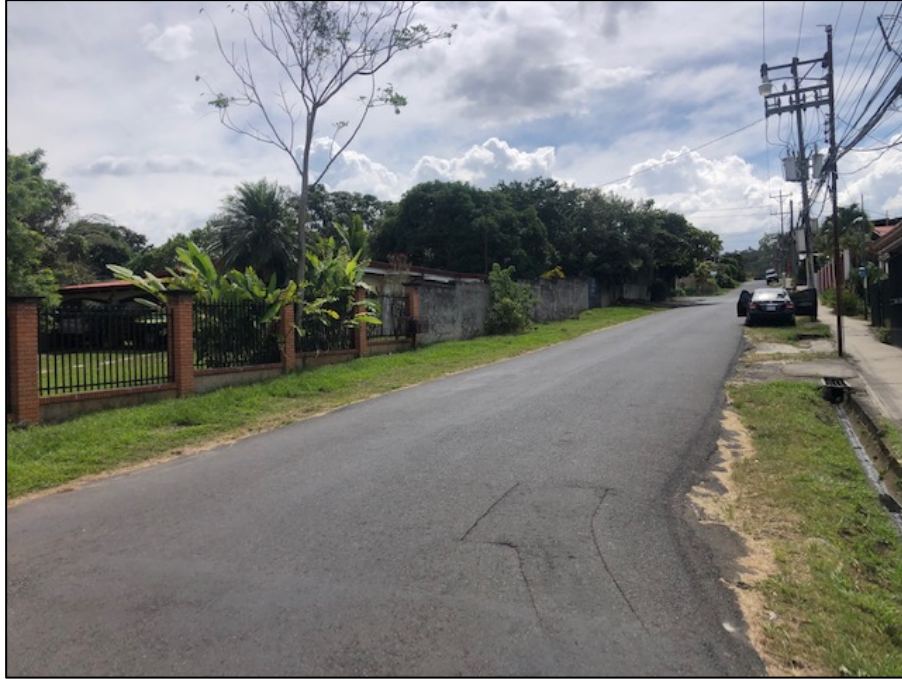
Figura 14. Tramo sin demarcación vial y solo una acera en costado este.
