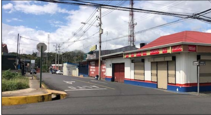
Figura 34. Carpeta sin grietas ni agregado grueso expuesto, aceras en ambos lados
