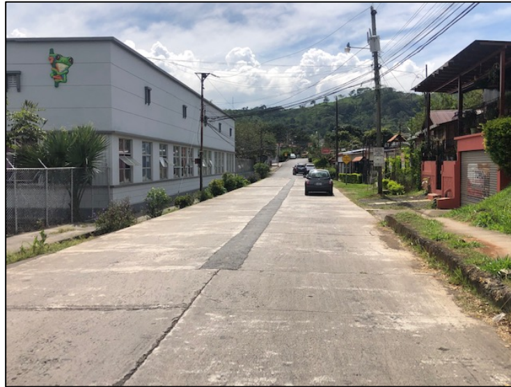
Figura 21. Tramo de la calle 2 en concreto, sin señalamiento horizontal, aceras incompletas.
