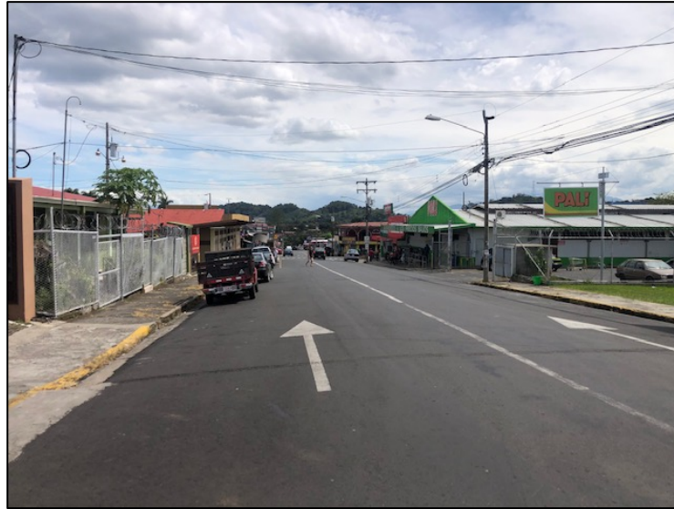
Figura 48. Carpeta sin grietas ni agregado grueso expuesto, aceras en ambos lados.
