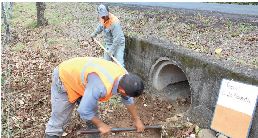
Miembros de Microempresa COOPETARIRE R.L inspeccionando una alcantarilla
