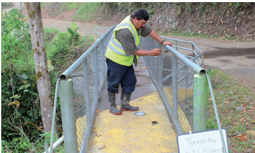
Miembro de Microempresa COOPEPUEBLOS UNIDOS R.L inspeccionando un puente
