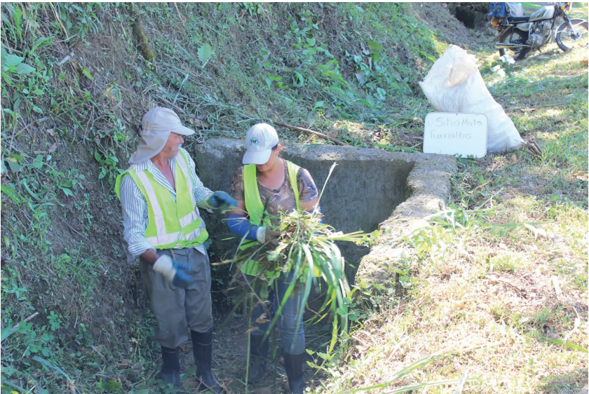
Miembros de Microempresa COOPEPUEBLOS UNIDOS R.L inspeccionando una alcantarilla
