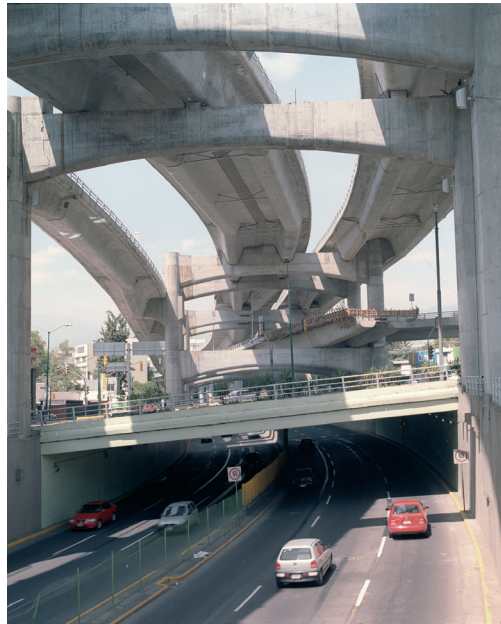
Fig. 9/ México D.F. Periférico elevado.
