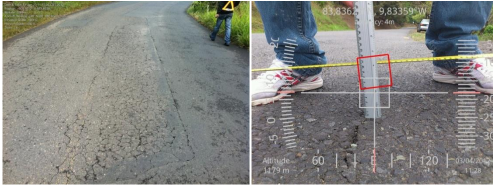
Figura 5. Ejemplos de cuero de lagarto (izquierda) y deformación por hundimiento (derecha) en la superficie de rodamiento de la ruta 224. (Fuente: Autor)
