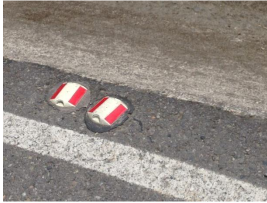
Figura 7. Captaluces colocados de forma adyacente en la ruta 225
