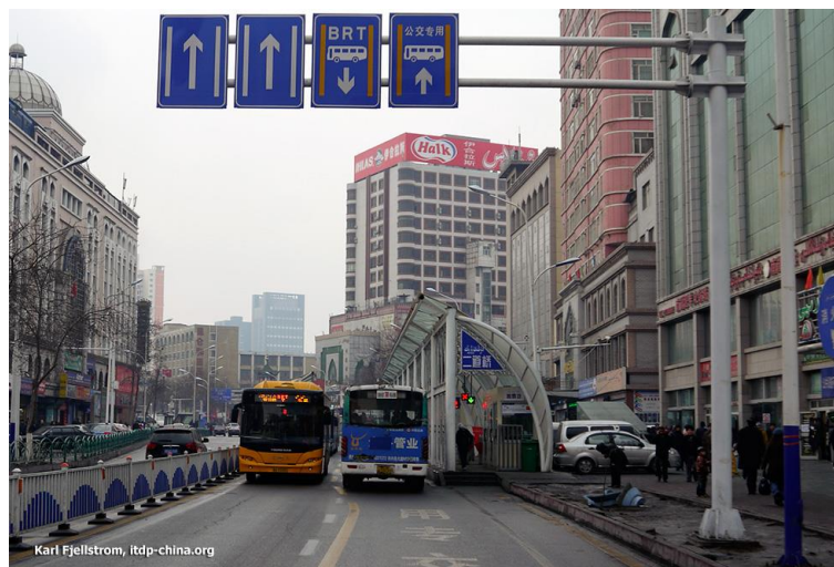
Figura 105. Contraflujo alineamiento lateral en Urumqi, China
