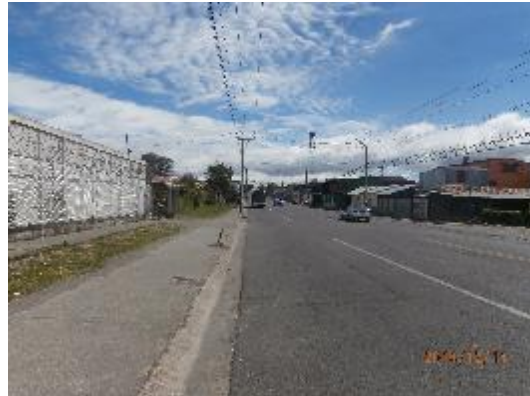
Foto 2. Tramo Terminal de Buses Lomas del Río - cancha de fútbol ceras Jhonnson
