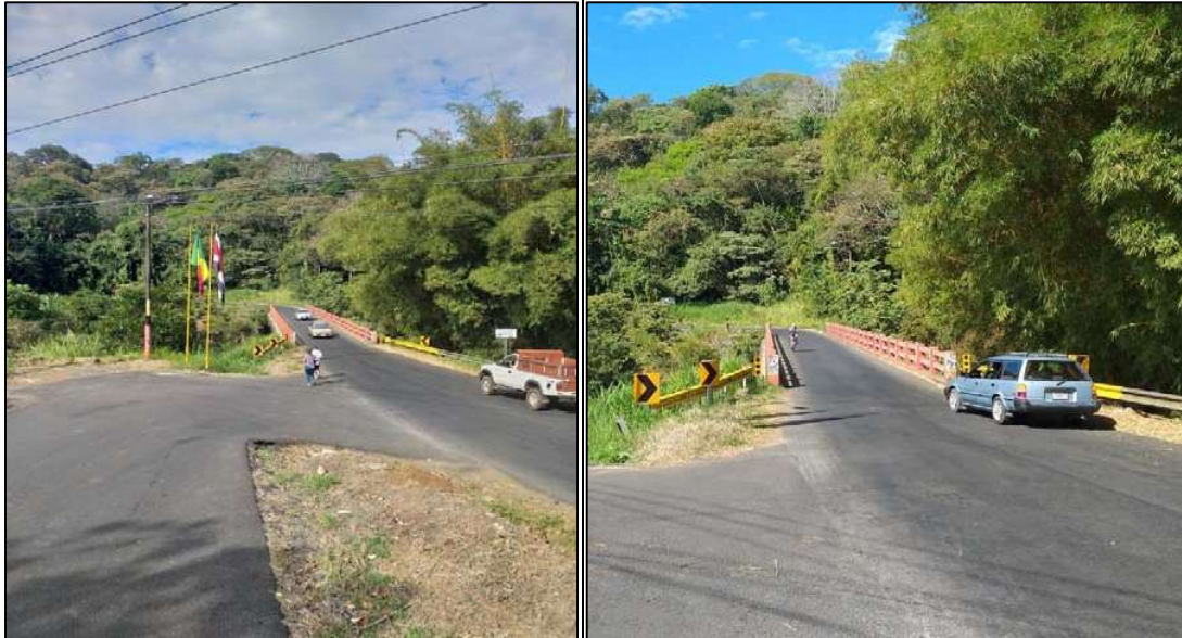
Figura 7. Presencia de Peatones y Ciclistas
