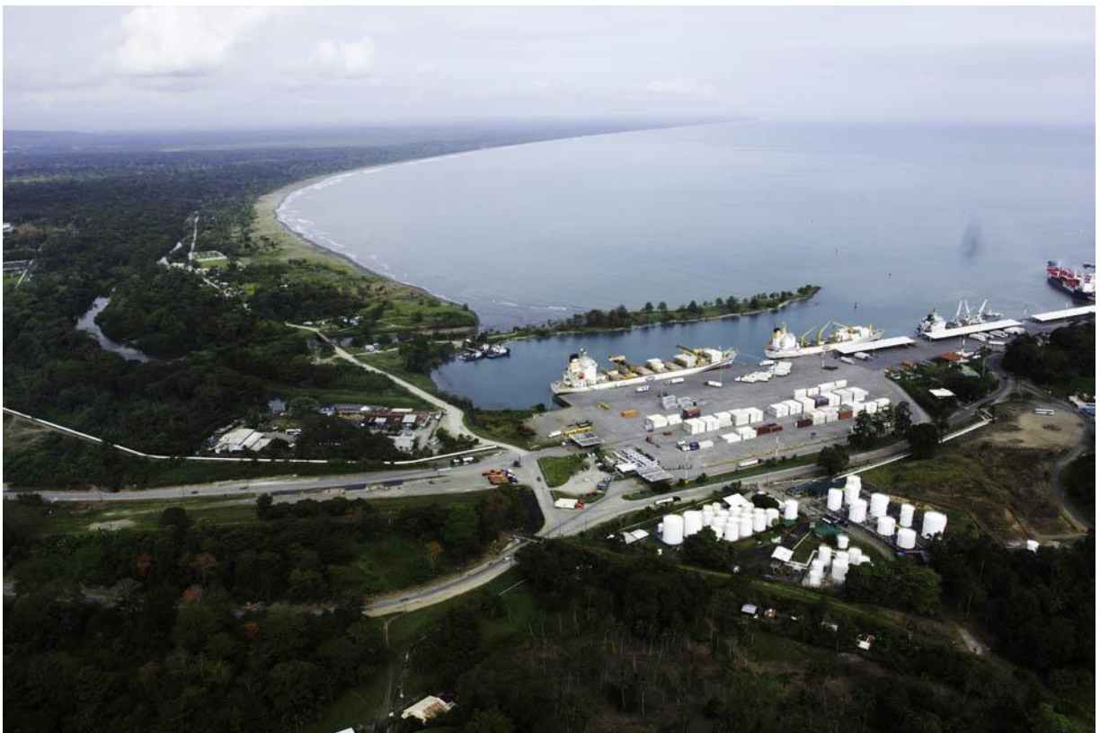
Vista aérea de Puerto Moín.
