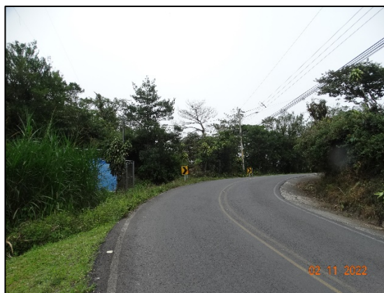
Figura N° 4. Señalamiento preventivo, sin aceras
