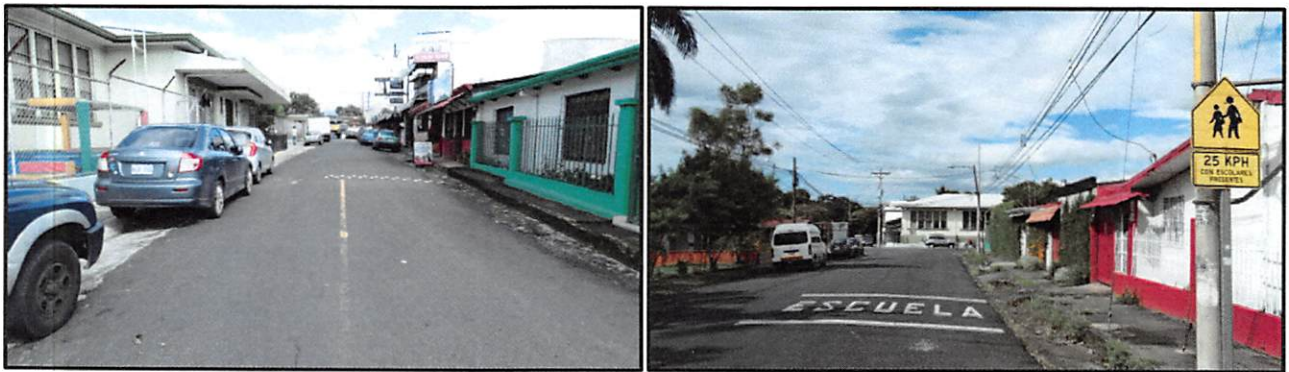
Imágenes N°2 y N°3. Estado de la superficie de rodamiento y señalización vial existente. Fuente: elaboración propia, diciembre de 2018.
