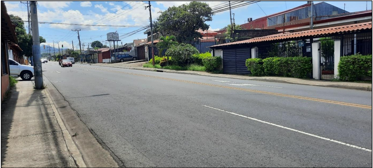
Figura 12 Intersección calle El Sendero - Ruta Nacional N.º 3, Río Segundo de Alajuela.
