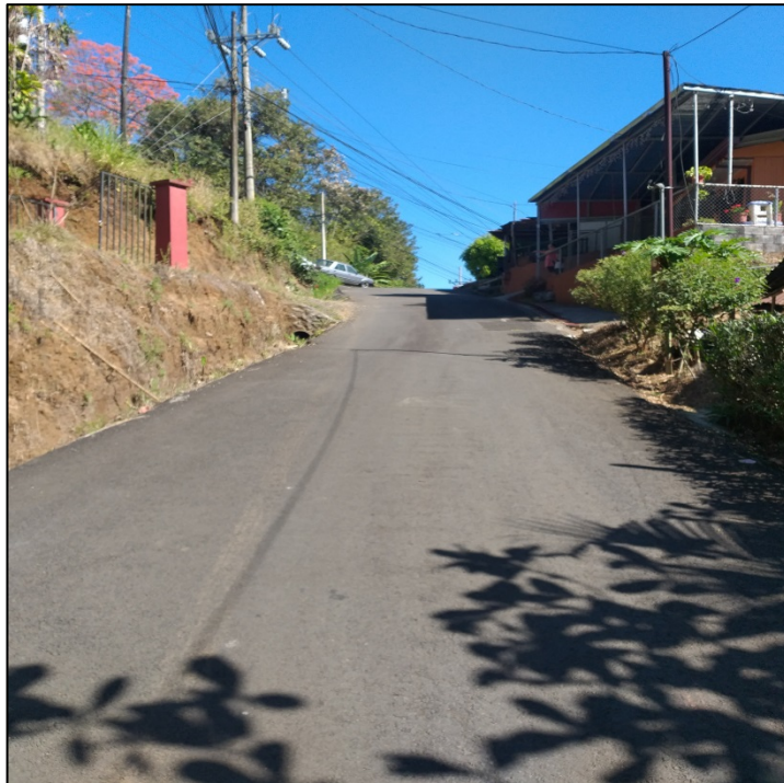
Figura N° 3 Calle en estudio, sentido sur – norte, sin aceras, márgenes con caño
