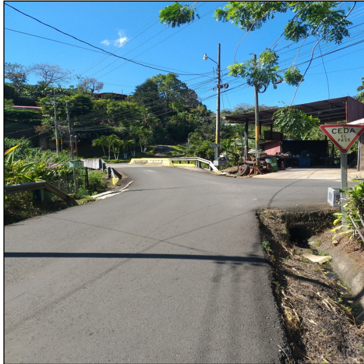
Figura N° 4 Puente Angosto y señalización sobre Calle Muñoz
