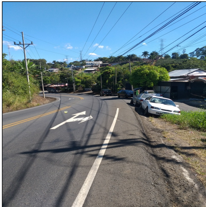
Figura N° 5 Acceso sobre Ruta Nacional N°141, sentido suroeste – noreste.
