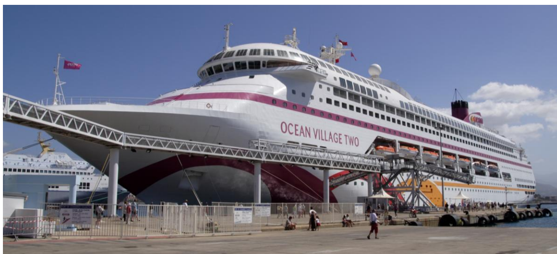
Figura 8-1 Aplicación de un puente peatonal para separar el tráfico pasajeros del tráfico de carga en el Terminal cruceros/ro-ro de Ajaccio
