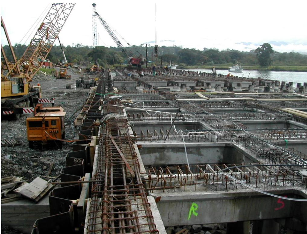
Figura 8-3 Vista general de las obras de construcción del muelle Taiwanés (agosto 2002)
