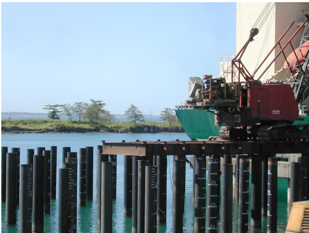
Figura 8-2 Hincado de pilotes en acero para el muelle Taiwanés (febrero 2002)
