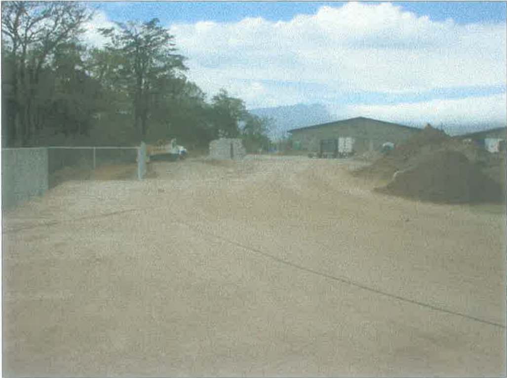
Vista adelante de corredor antes del cruce de la Uruca
