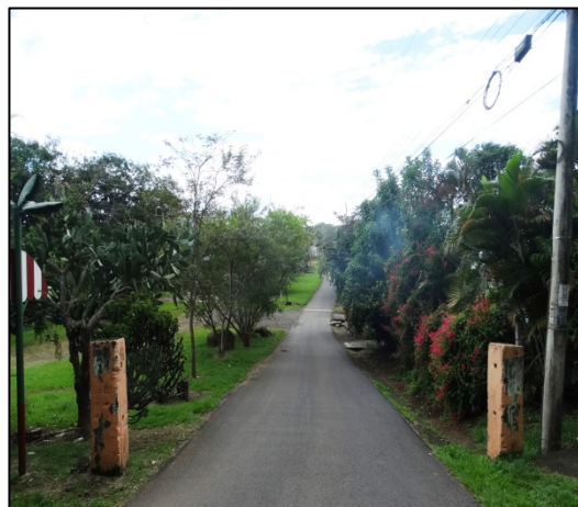
Figura N° 5. Calle cantonal sin señalamiento vial
