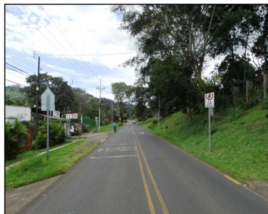
Figura N° 3. Asfalto sin grietas y señalización vial existente
