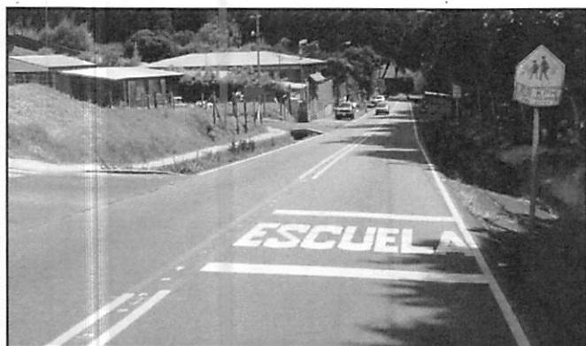
Figura 1. Tramo de Ruta Nacional N°712, cercano al sector de las instalaciones del CEN CINAI, Fraijanes, San Isidro, Alajuela, Alajuela. Vista sentido Norte- Sur.
