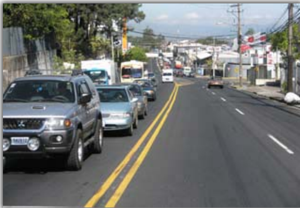
En los trabajos de recarpeteo de la Radial Uruca se empleó el uso de geotextiles
