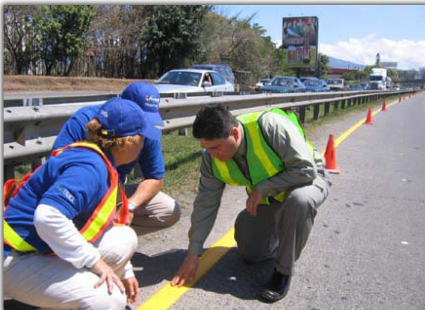
El Viceministro de Obras Públicas, Dr. Pedro Castro Fernández en supervisión de trabajos de demarcación
