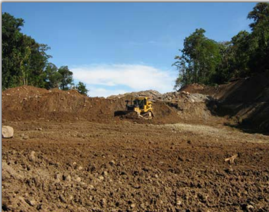
Movimientos de tierra en ruta Sifón-La Abundancia
