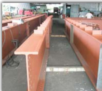
Construcción de vigas para puente sobre río Pangola
