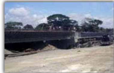
La estructura que se construye sobre el río Naranjo tiene una longitud de 198 metros
