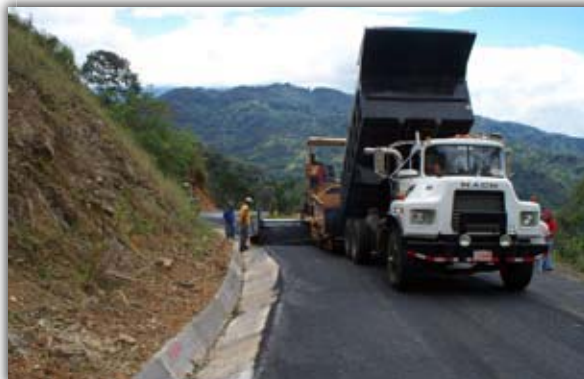
Trabajos de mejoramiento en ruta Palmichal-Chirracá
