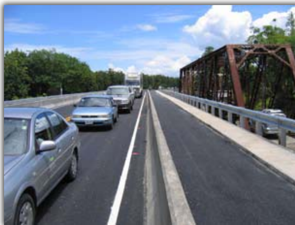
Puente sobre el río Paquita ubicado entre Parrita y Quepos
