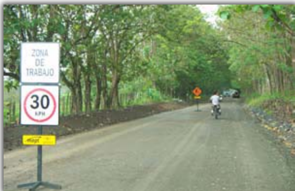
Rincón-Puerto Jiménez es otra de las rutas nacionales sujetas a mejoramiento
