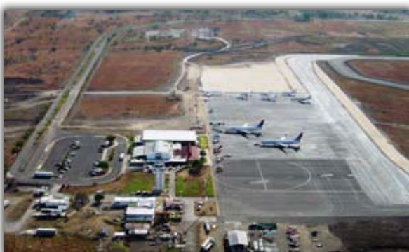
Construcción de 34.500 m 2 de plataforma, del sistema de iluminación y de la plataforma de equipo a tierra, son algunas de las mejoras destacadas en el Aeropuerto de Liberia
