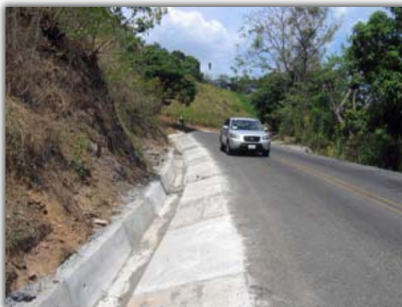
Mejoramiento de drenajes ruta Manolos-Desmonte-Orotina
