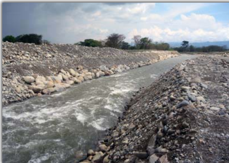
En el río General en Pérez Zeledón también se realizaron labores de canalización
