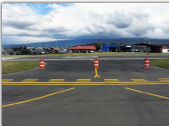
Para mejorar el acceso a los hangares en el aeropuerto Tobias Bolaños de Pavas se recarpeteó la superficie de rodamiento de la pista y se realizó la señalización horizontal
