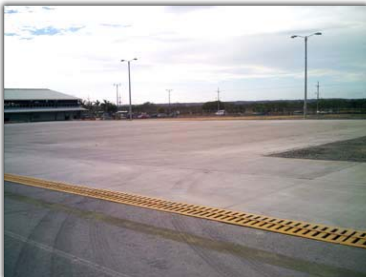
Plataforma construida en Aeropuerto Internacional Daniel Oduber Quirós, Liberia
