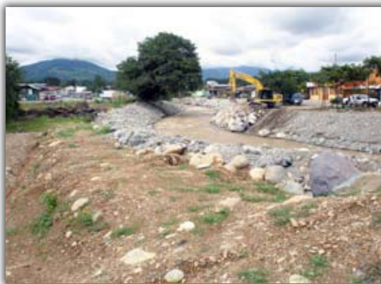
Trabajos de protección de marginal y canalización, río Quebradas en Pérez Zeledón
