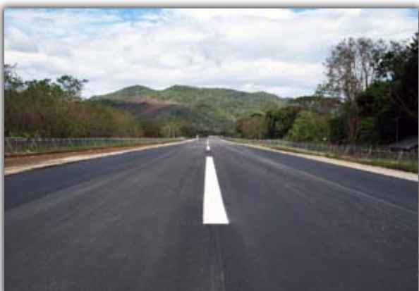
En el Aeródromo de Nosara se puede observar el excelente estado de la pista, debidamente demarcada y la malla que cubre todo el perímetro.
