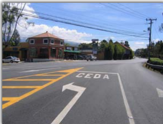
Trabajos de recarpeteo y demarcación, carretera a Tres Ríos
