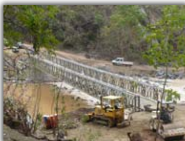
Estructura tipo bailey construida sobre el río Parrita, Bijagual
