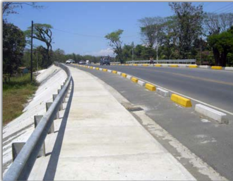
El puente sobre el río Parrita ubicado entre Quepos y Savegre, cuenta con ciclovías, iluminación y aceras peatonales
