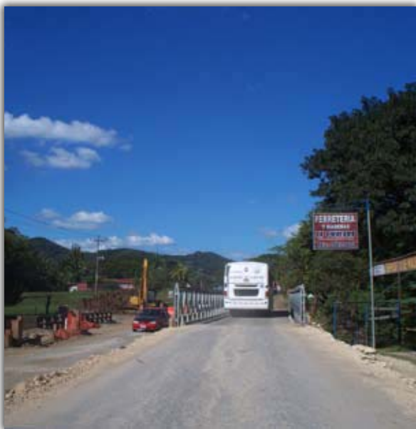
Puente sobre el río Grande, Nicoya
