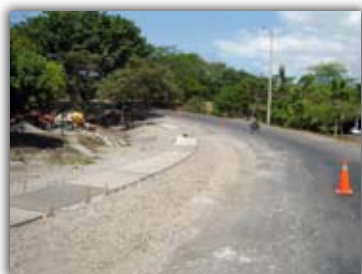
Durante el periodo el MOPT ha promovido la construcción de ciclovías
