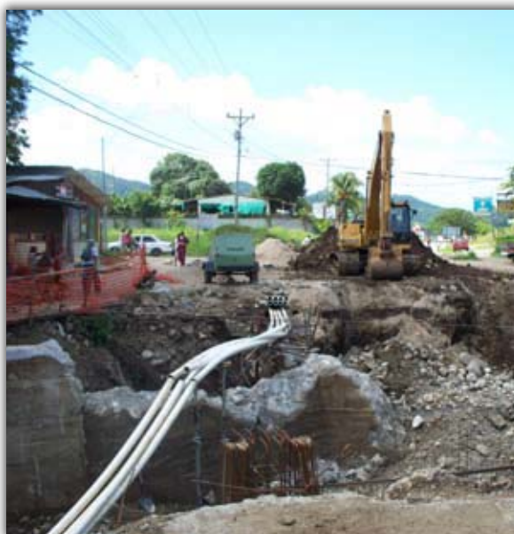
Construcción de puente sobre el río Perico, Nicoya
