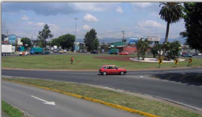
La rotonda de Alajuelita se sustituirá por un puente elevado similar al ubicado en la antigua rotonda de la Y Griega
