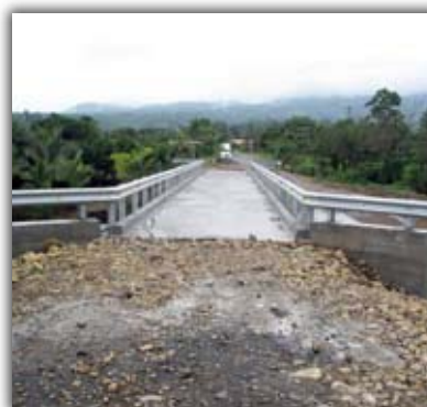
Puente sobre el río Burro, San Carlos
