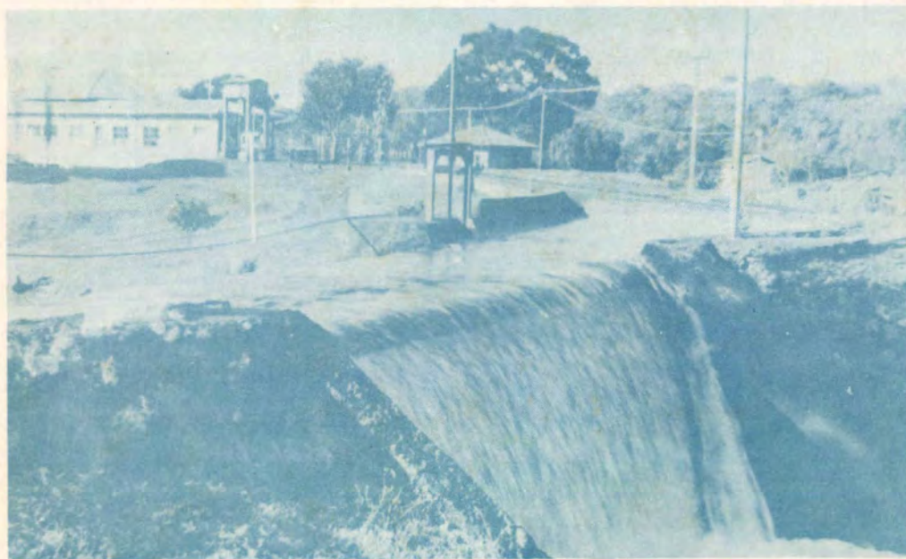
VERTEDERO DE EXCEDENCIAS DEL CANAL DE LA PLANTA ELECTRICA DE TACARES
