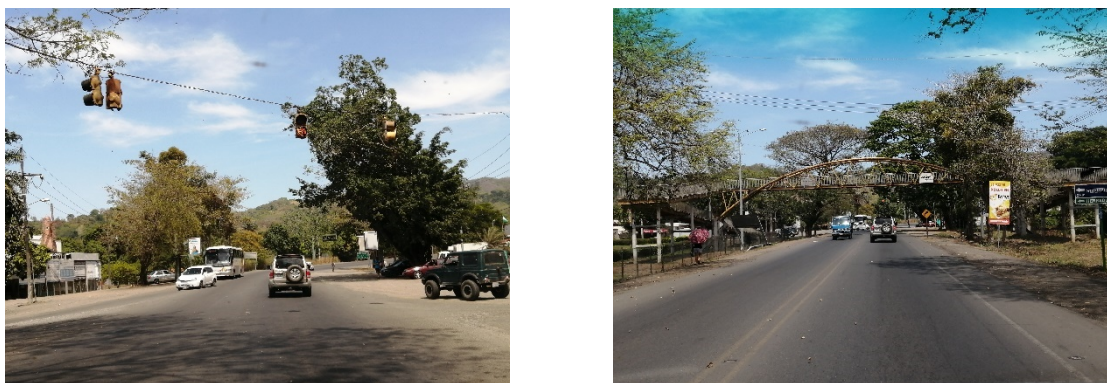
Figura 33. Semáforo de prevención y puente peatonal en Herradura
