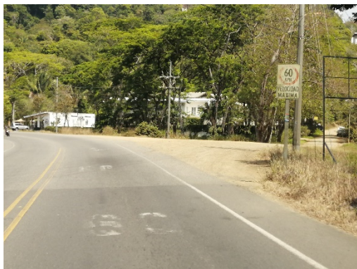
Figura 23. Demarcación vial horizontal y vertical en visible deterioro
