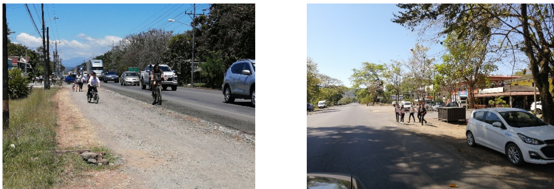
Figura 31. Falta infraestructura peatonal y ciclista sobre Ruta Nacional N° 34
