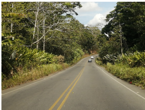
Figura 9. Ancho de vía con dos carriles de circulación, sector de Esterillos
