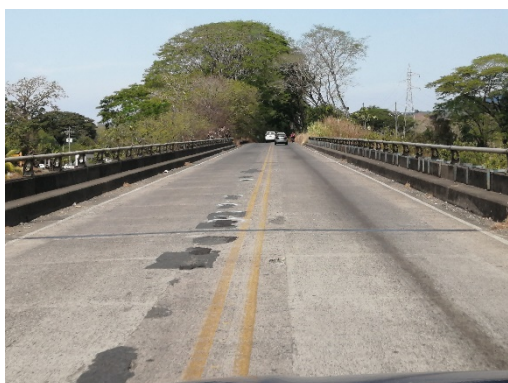
Figura 21. Puente sobre Río Tulín
