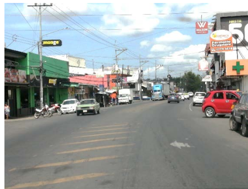
Figura 23. Demarcación vial horizontal y vertical en visible deterioro
