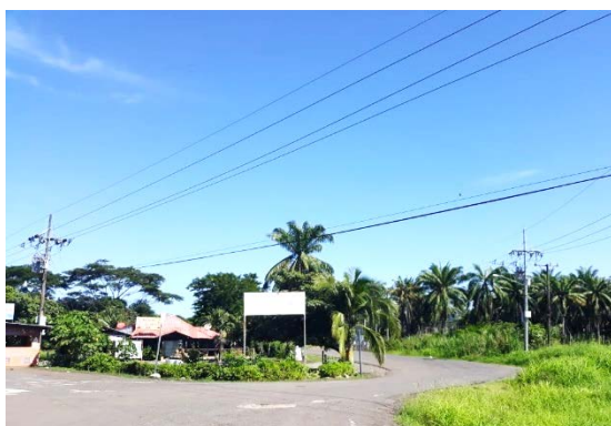
Figura 17. Intersección con Ruta Nacional N° 239 en asfalto
