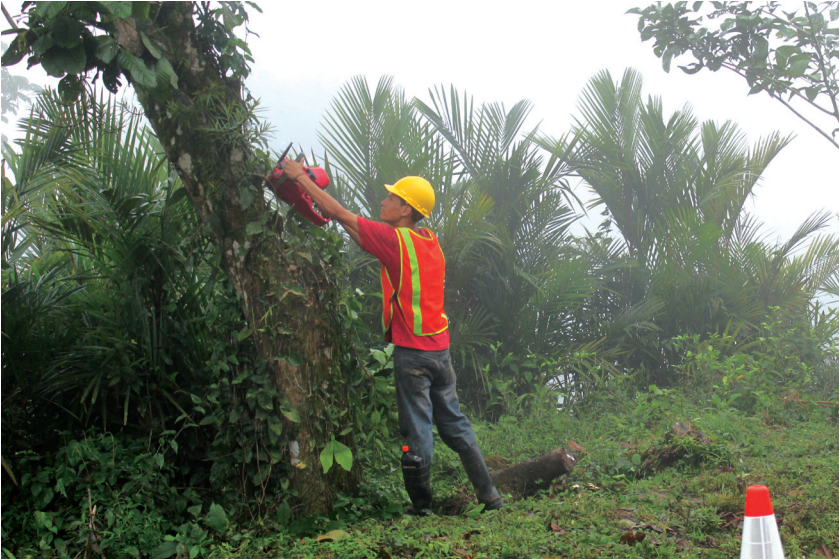
Labores de descuaje en camino La Paz, Katira, cantón Guatuso
