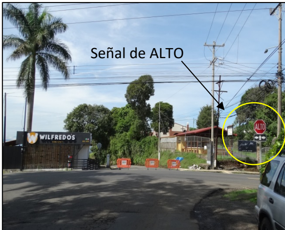
Figura N° 6 Fin de la ruta, intersección Ruta Nacional N°107, con señal vertical de ALTO y no hay señalamiento horizontal.
