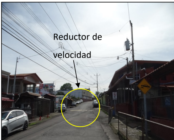
Figura N° 5 Reductores de Velocidad con señalamiento vial, borroso o inexistente.
