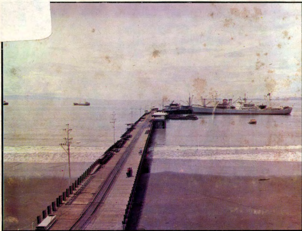
MUELLE DE PUNTARENAS
