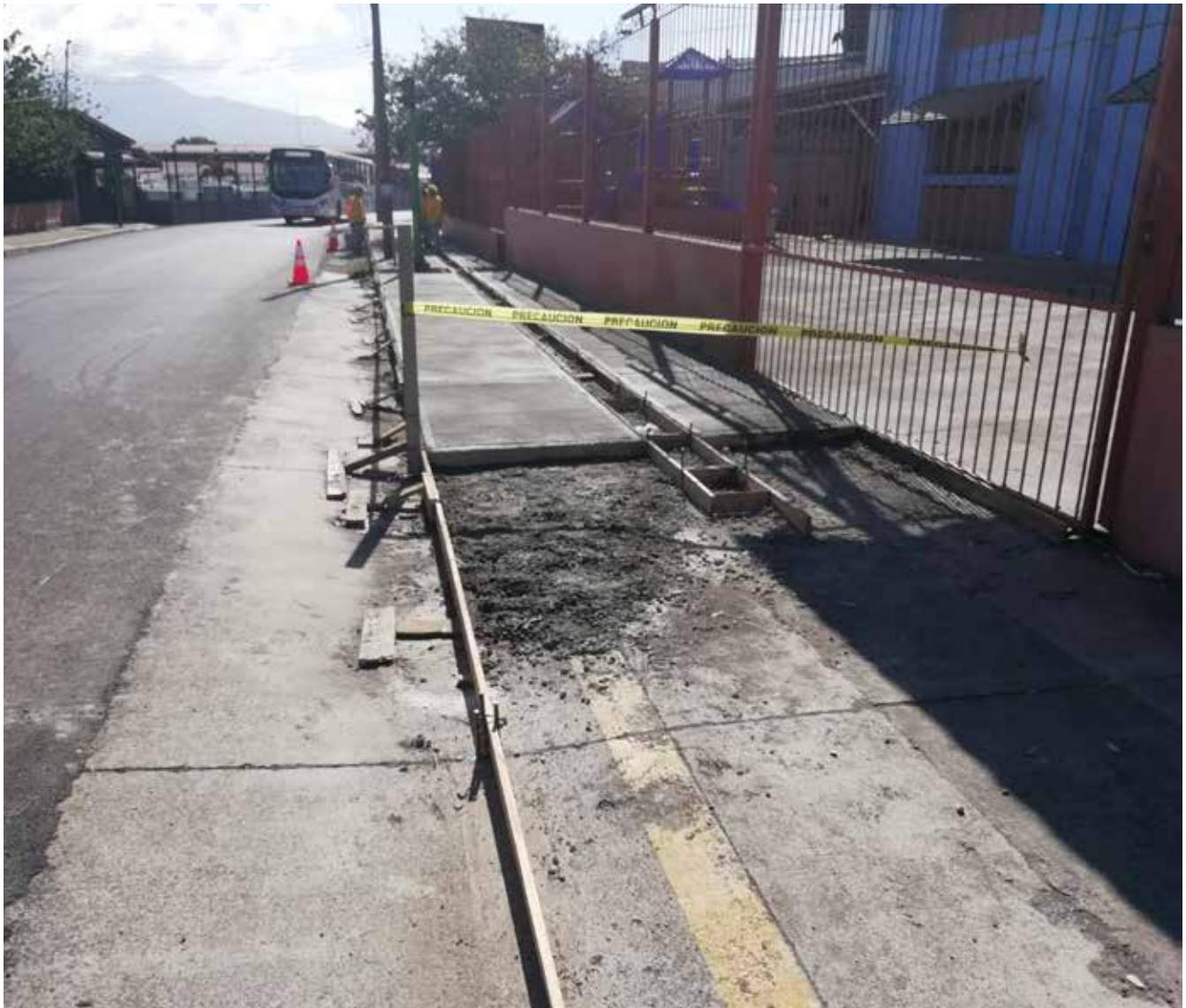
Imagen 74. Obras de rehabilitación del espacio peatonal realizadas por CONAVI, en el marco de la implementación del carril exclusivo en Guadalupe. Fuente: SPS-MOPT, 2020.
