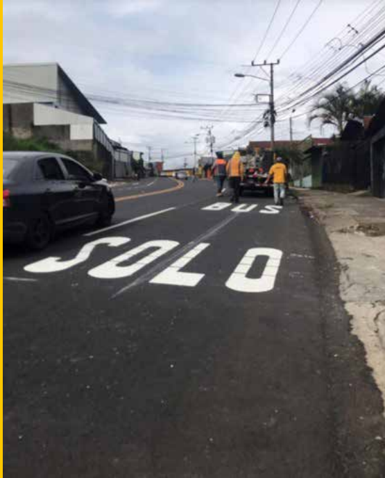
Imagen 76. Obras de demarcación Horizontal carril exclusivo. Fuente: CONAVI. 2020.
