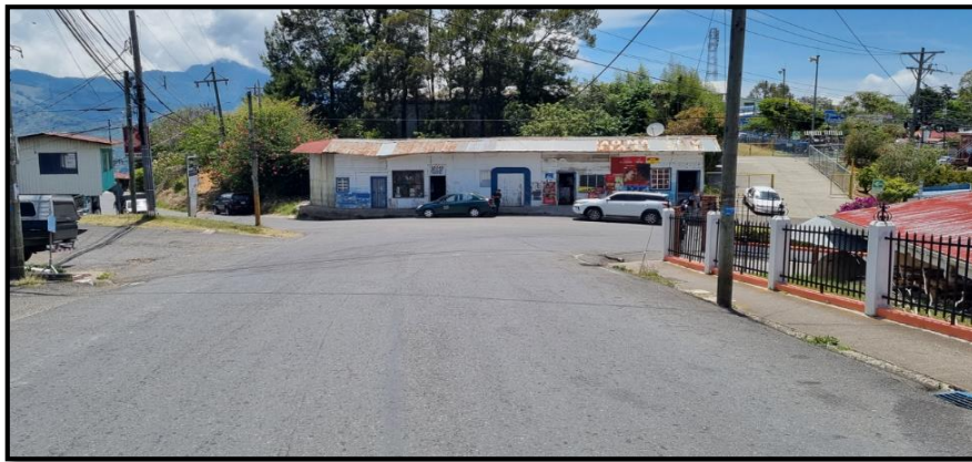
Figura 3 Intersección de la Ruta Nacional N°222 y Calle 36, Frailes de Desamparados.
