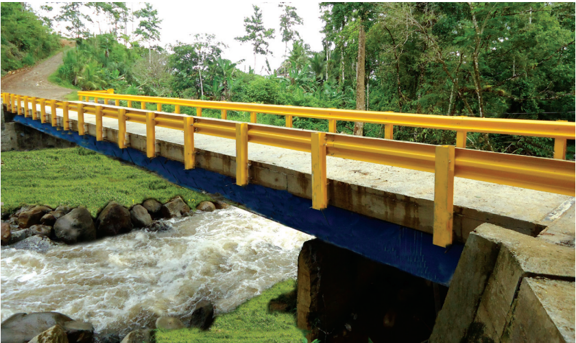
Puente en camino a Guatuso, Alajuela.
