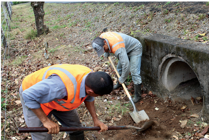
COOPETATIRE R.L en limpieza de alcantarilla en La Foresta. Cantón Pococí
