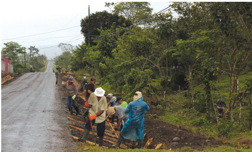
Construcción de cunetas o canales en Florida, Katira, cantón de Guatuso
