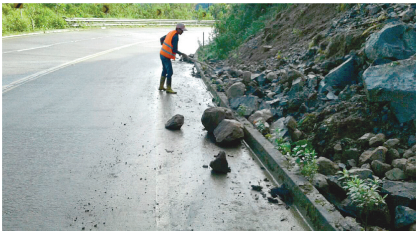
Labores de atención de derrumbes en caminos cantonales
