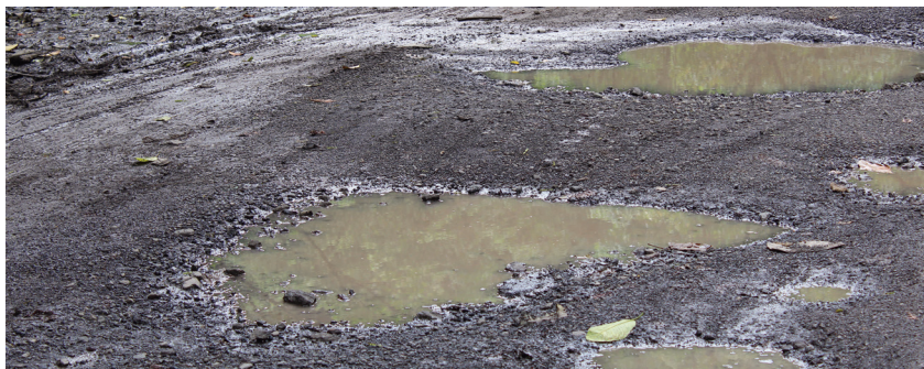
Labores de atención de emergencia en caminos cantonales
