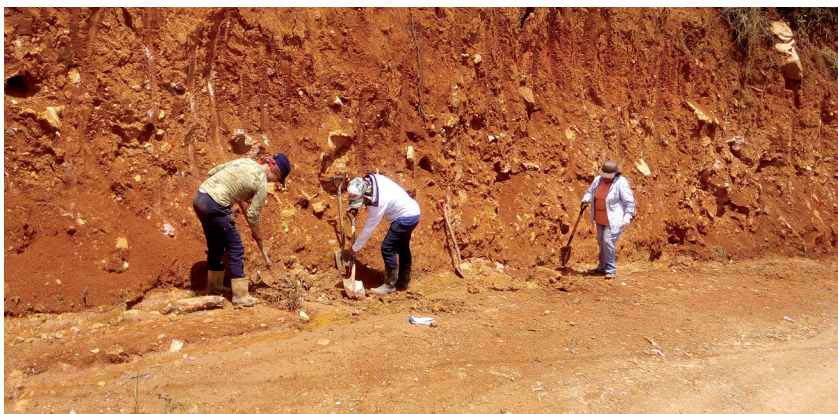
Mantenimiento Vial en Proyecto PRVC-I, cantón Tarrazú
