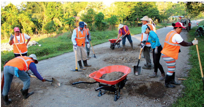
Labores de bacheo en lastre. COOPETARIRE R.L. Santa Rosa de Tarire, cantón de Pococí
