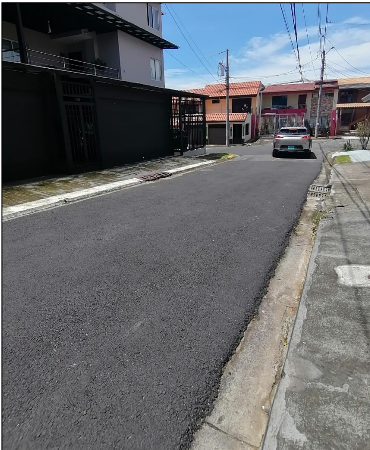
Figura 5. Sección recarpeteada, vía cantonal 409086-00, Urb. Lomas de San Pablo, Heredia. Fuente: Propia.
