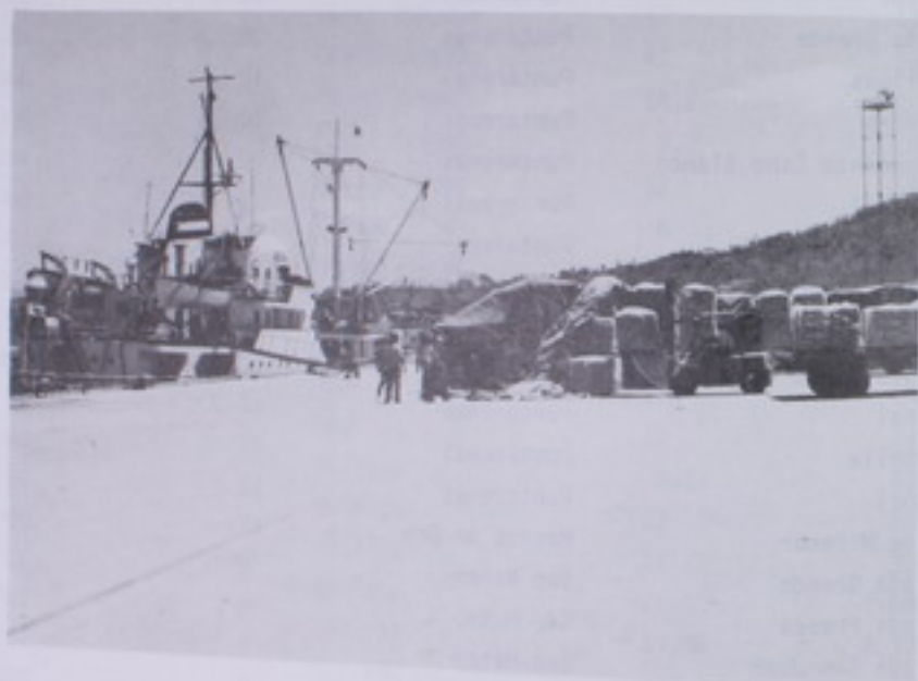
Complejo Portuario de Caldera, con tres atracaderos para barcos convencionales y una rampa para movilización de carga bajo el sistema de roll-on roll-off.
