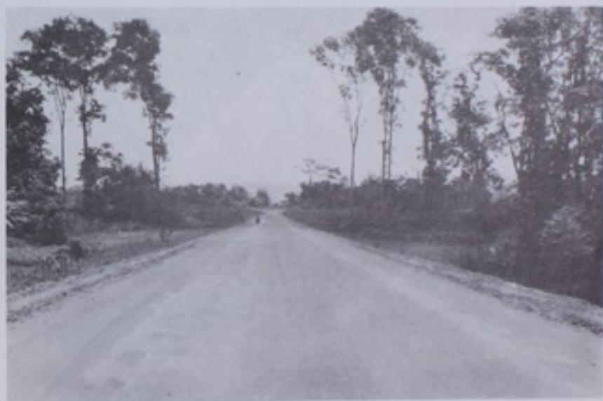
Vista panorámica de la nueva carretera en construcción entre San José - Siquirres - Puerto Viejo.
