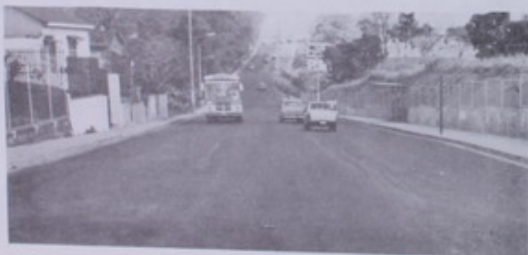
La carretera que une el Cantón de Tibás con el centro de San José, se agilizó notablemente con los trabajos de mejoramiento y ampliación, que realizó el Ministerio de Obras Públicas y Transportes.
