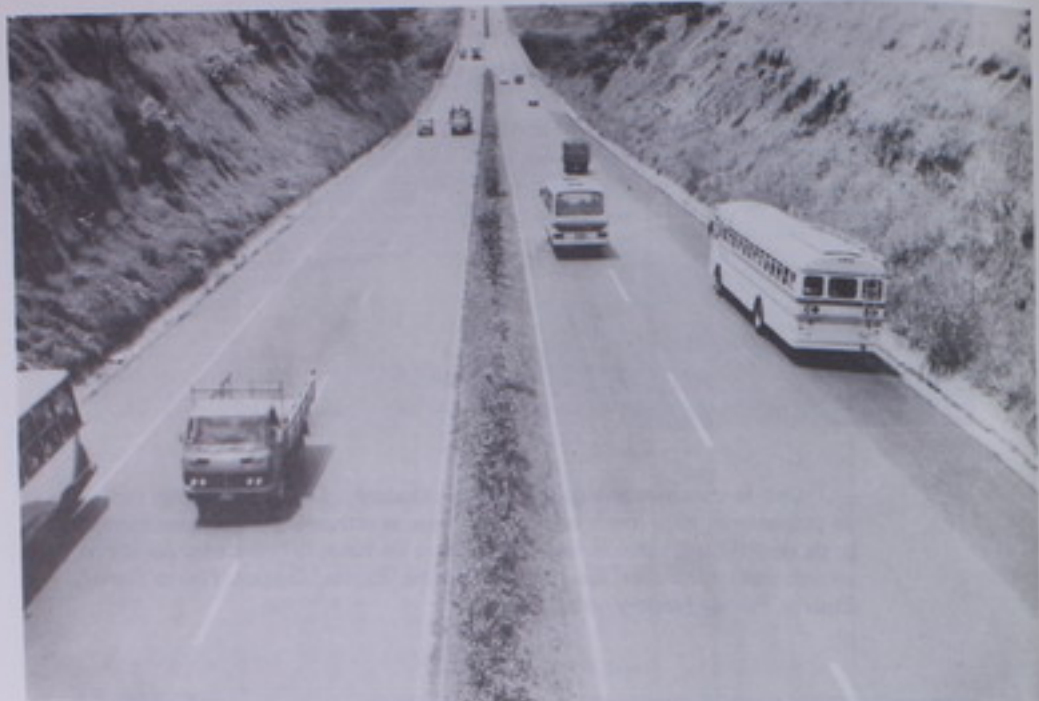
Con novedoso método se utilizó para la restauración del pavimento de la Autopista General Caffer y Bernardo Soto. La restauración de la Autopista, forma parte de un amplio programa que se financia con fondos donados por AID.
