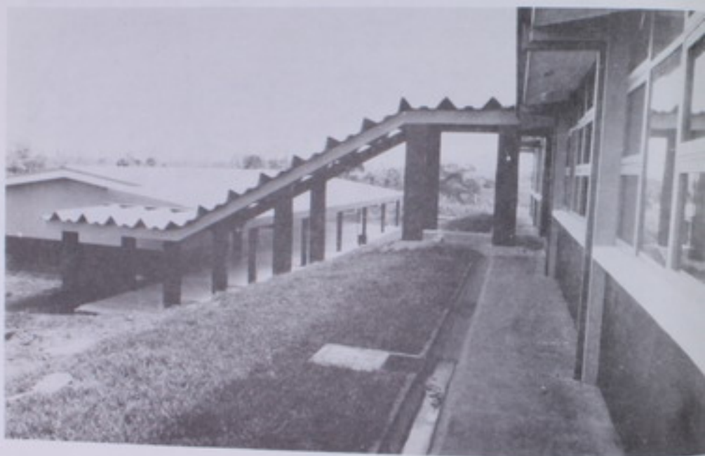
Parte de las instalaciones del Colegio Santa Rosa de Cutris en el cantón de San Carlos. Se encuentra totalmente terminado y beneficia a los estudiantes de la zona.
