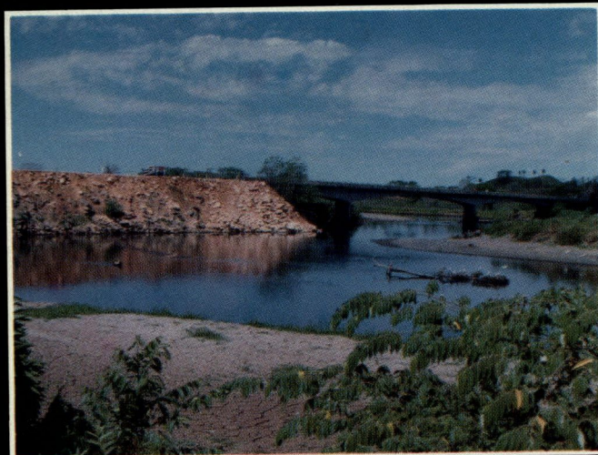
Relleno efectuado por el MOPT sobre el río Tárcoles
