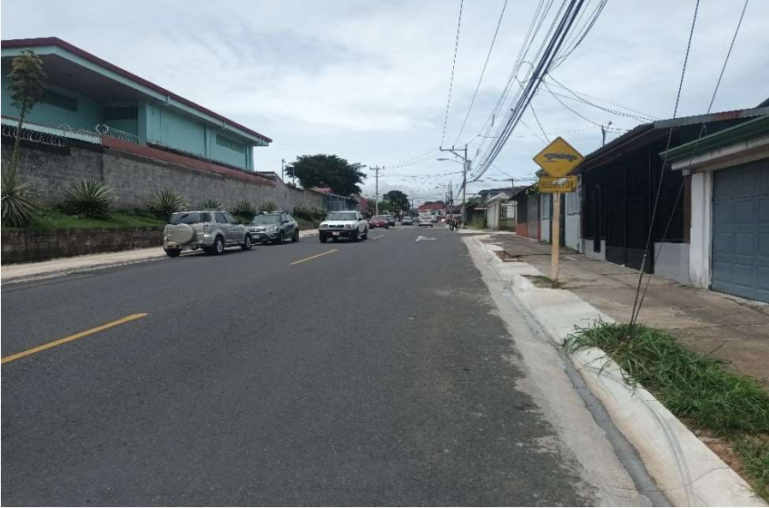
Figura 6. Costado sur Colegio Claretiano, Avenida 21.
