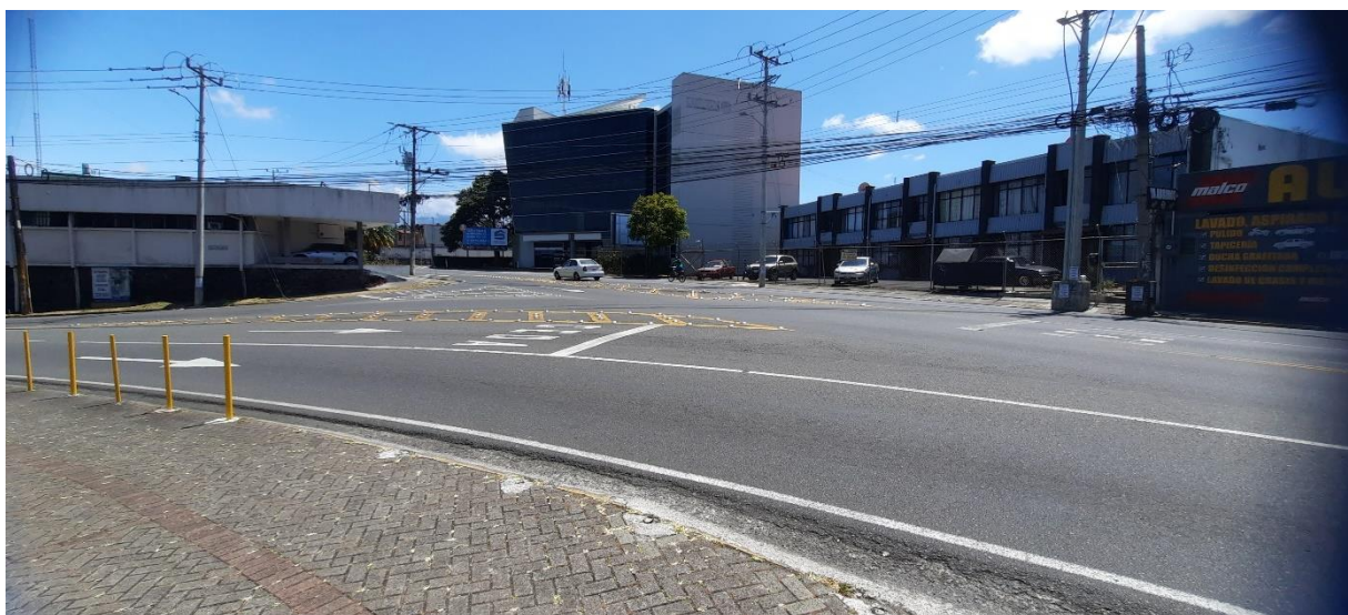
Figura 4 Vista este de intersección RN N.º 201-RN N.202, Montes de Oca, San José. Fuente: Propia.
