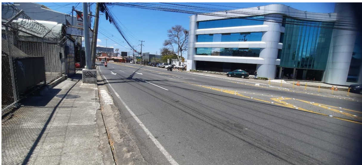
Figura 5 Vista oeste de intersección RN N.º 201-RN N.202, Montes de Oca, San José. Fuente: Propia.
