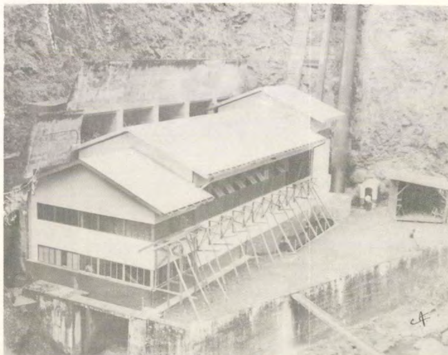
CASA DE MAQUINAS DE LA PLANTA ELECTRICA DE TACARES
