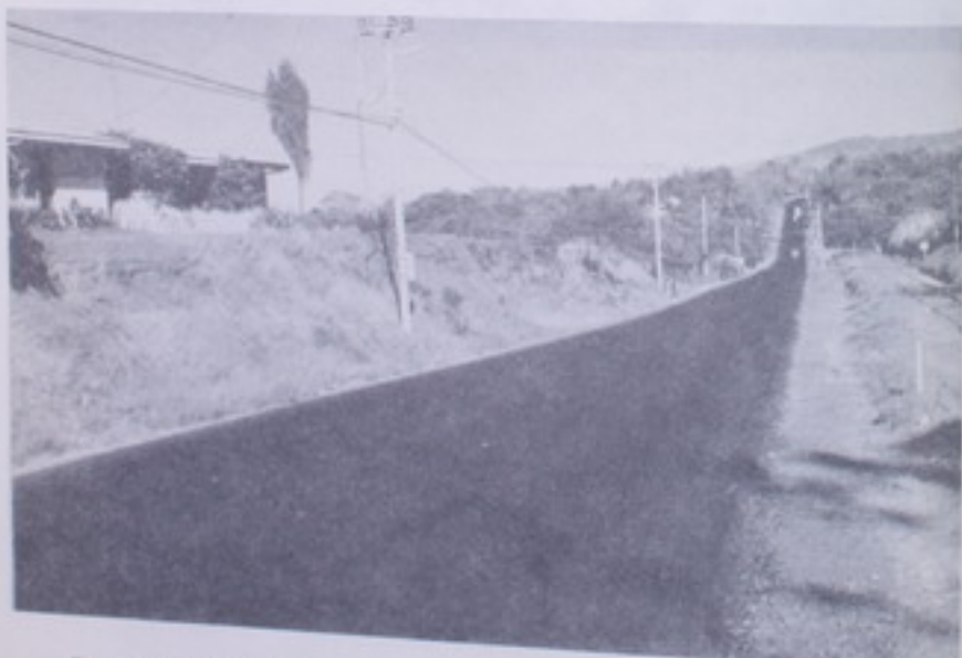
En la carretera entre El Coco y Alajuela se colocó una carpeta asfáltica para mejorar la superficie de rodamiento.
