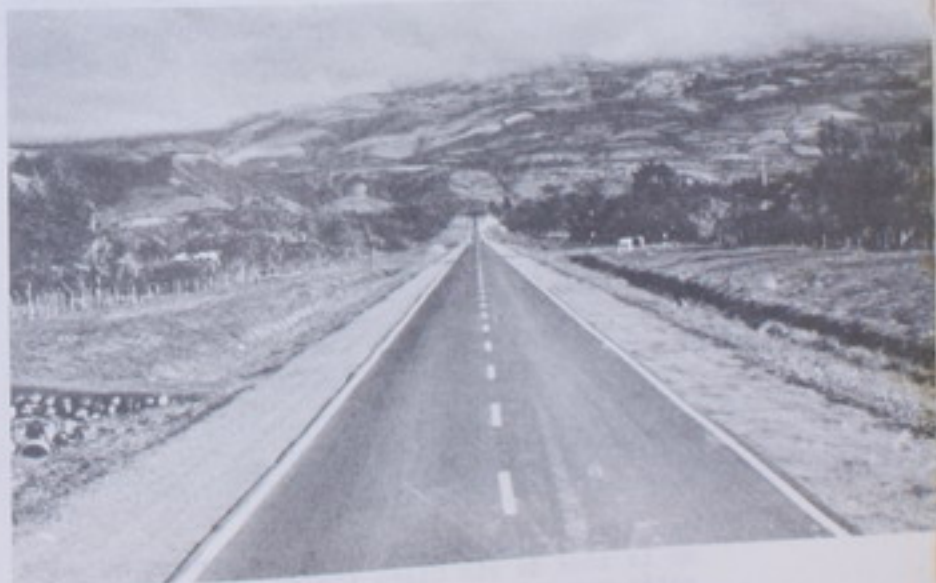
TARAS-SAN ISIDRO DE EL GENERAL: Proyecto de 115.10 Kms. con un costo de $ 8.355.000. Obra iniciada en 1967.
