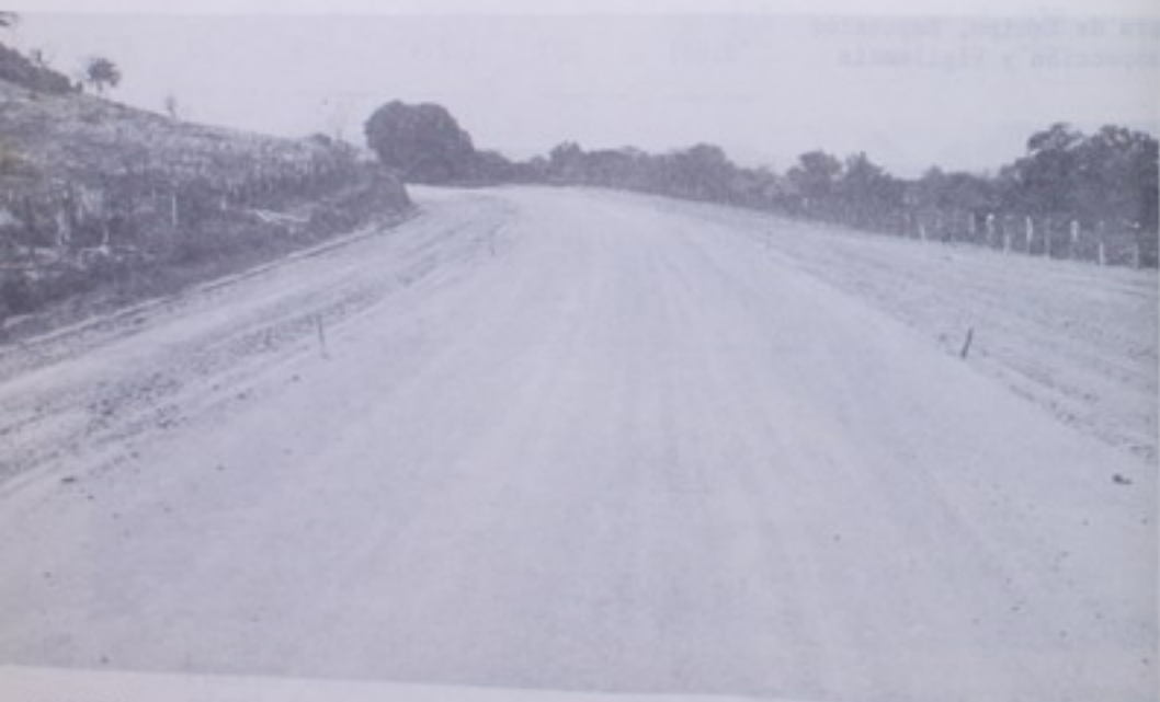
JICARAL-LEPANTO: Camino vecinal de la segunda etapa con una longitud de 10 Km.-Esta obra debe estar concluida en agosto de 1970.-
