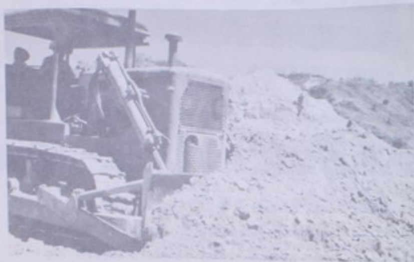
DESVIO DESMONTE-SAN MATEO
