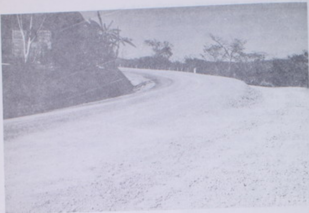
MANSION-BARRA HONDA: Esta vía tiene una longitud de 5 Km., habiéndose se realizado el 95% que restaba.-
