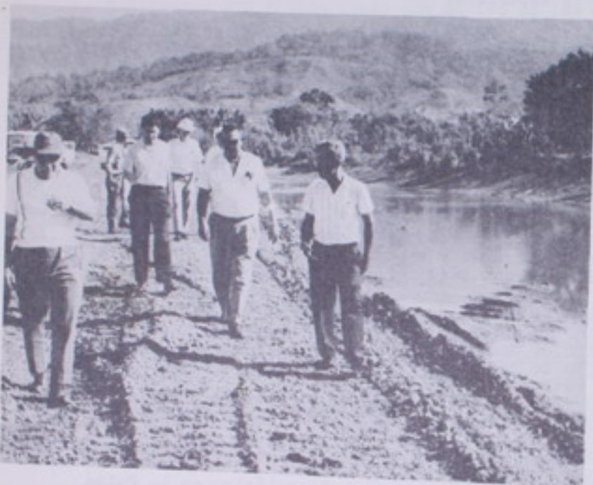
RIO BALZAR: Se llevó a cabo la canalización y desvío del río Balzar en Puerto Cortés, que tiene una longitud de 1.200 metros. Esta es una de las visitas de inspección que llevó a cabo el señor Ministro Ing. José J. Rodríguez Calvo con técnicos de Defensa Civil.
