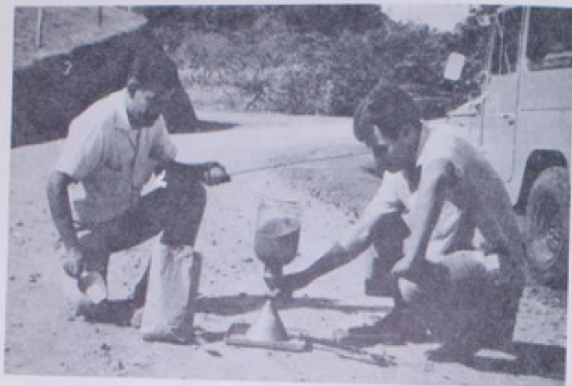
Chequeo o compactación de la subbase colocada en el proyecto
