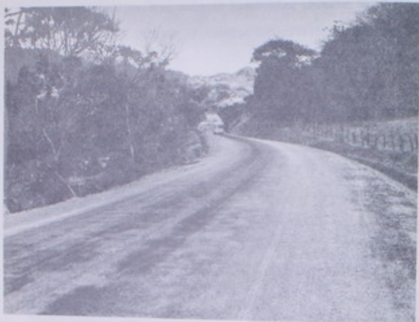
Interamericana-Miramar. Este proyecto tiene una longitud de 7.20 Kms. y un costo de £ 878.000. La obra quedó lista en 1968.
