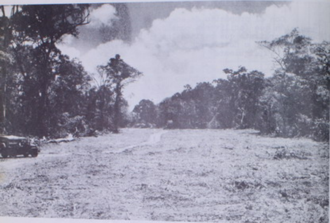
DESBOSQUE-SIQUIRRES-CEDAR CREEK: Este importante trabajo para la carretera a Limón, tiene una longitud de 43 Kms.
