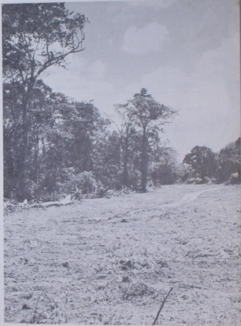
DESBOSQUE-SIQUIRRES-CEDAR CREEK: Este importante trabajo para la carretera a Limón tiene una longitud de 43 Km. Se finalizó setiembre 1967.-
