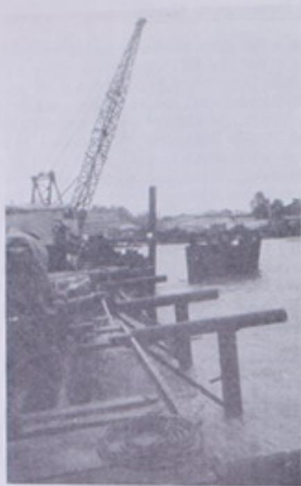
Colocación de la obra falsa para facilitar la hincada de pilotes en el Muelle provisional en Puerto Limón.
