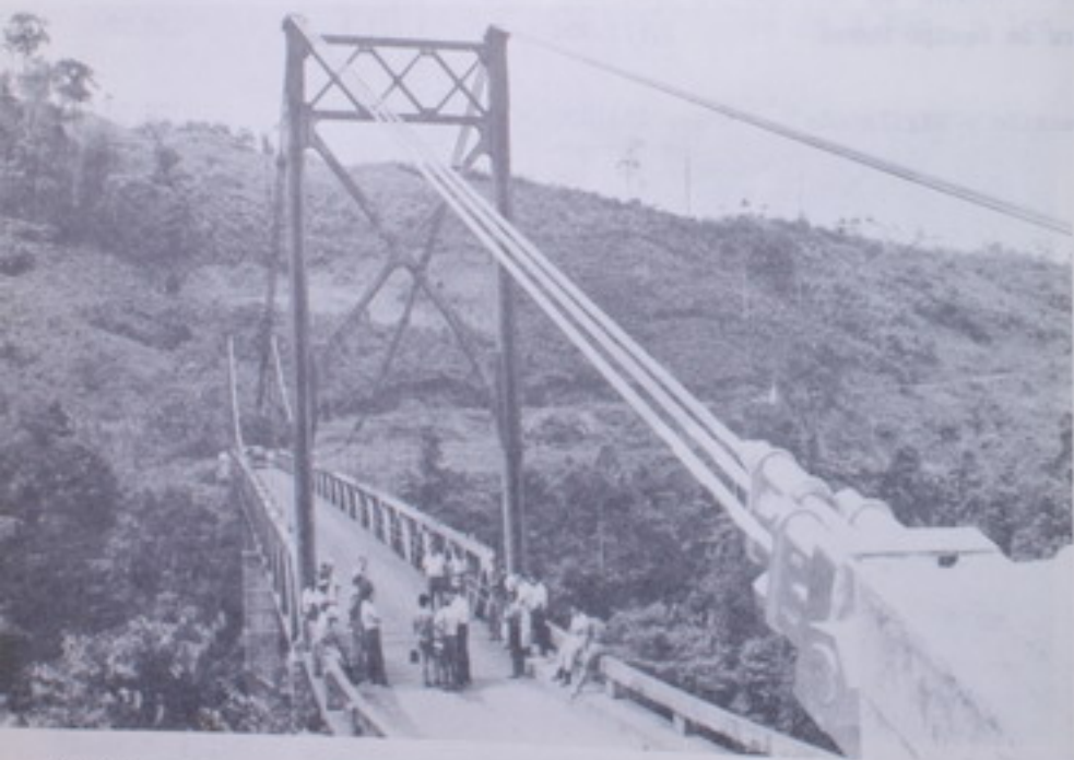
PUENTE PERAS BLANCAS: Esta importante estructura tiene un costo - de ₡ 1.987.000.- La obra se terminó el 8 de julio de 1966.-
