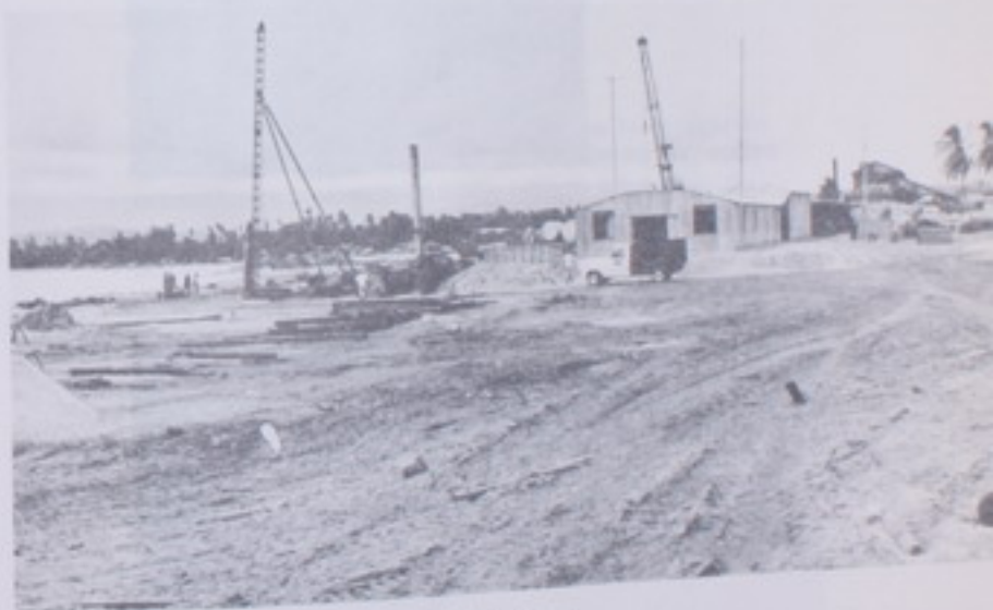
Lugar donde se construye el Muelle Bananero de Limón.
