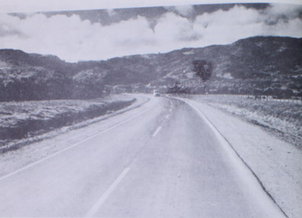
Proyecto entre Taras y San Isidro de El General
