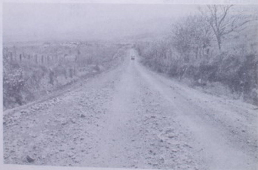
TILARAN-TIERRAS MORENAS: Este importante camino con un costo de ₡ 1.268.000. tiene realizado el 75% de los trabajos.-
