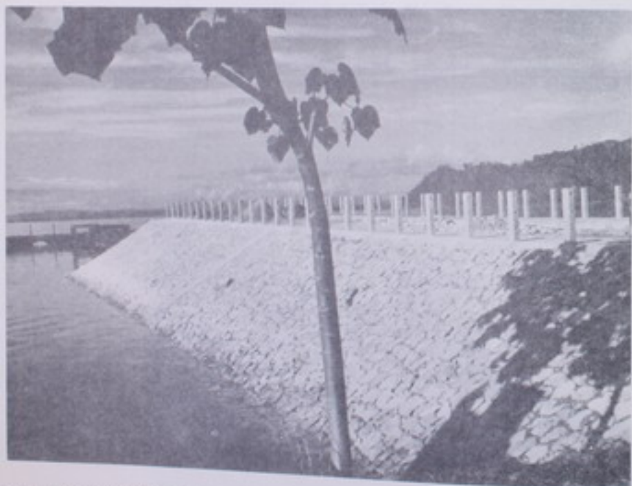
MUELLE DE CABOTAJE DE GOLFITO
