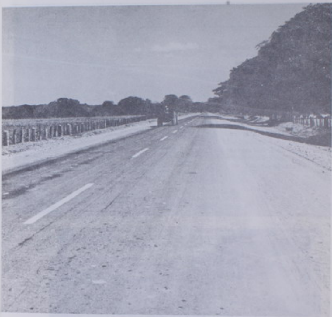
GUARDIA-BELEN: En esta administración se construyó el 50% que faltaba de esta carretera, la que tiene un costo de £ 5.168.000.-
