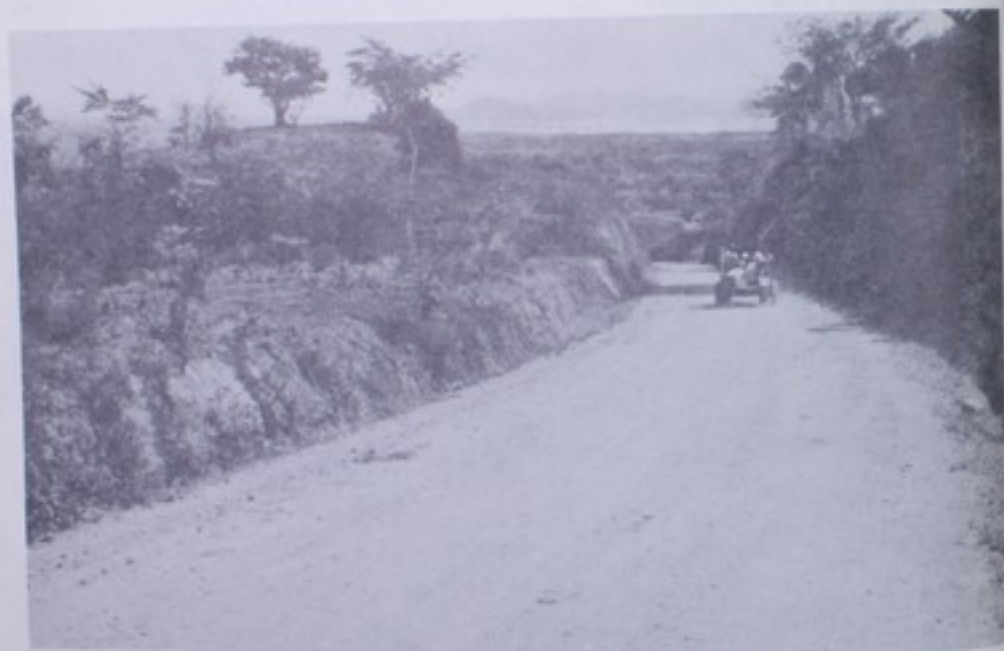
JICARAL-DOMINICA: Camino vecinal de 5.5 Km. con un costo de ₡1.559.0 Los trabajos se iniciaron en agosto 1968 y terminaron en mayo 1969.
