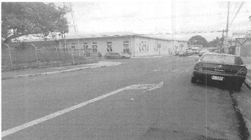
Figura 2. Condición actual de la intersección
