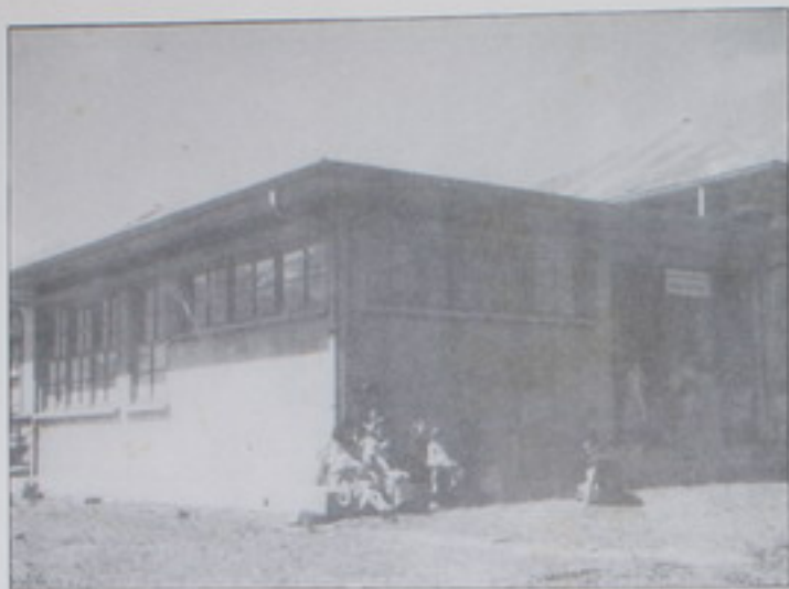
Vista parcial de la Unidad Sanitaria de Palmares.
