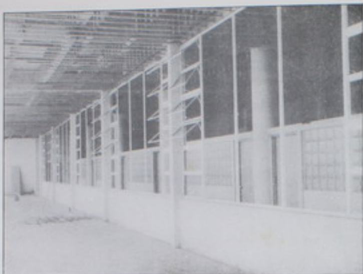
Vista interior del edificio El Coco. (en construcción)
