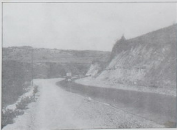
Ampliación carretera San José - Cartago, sección Ochomogo.
