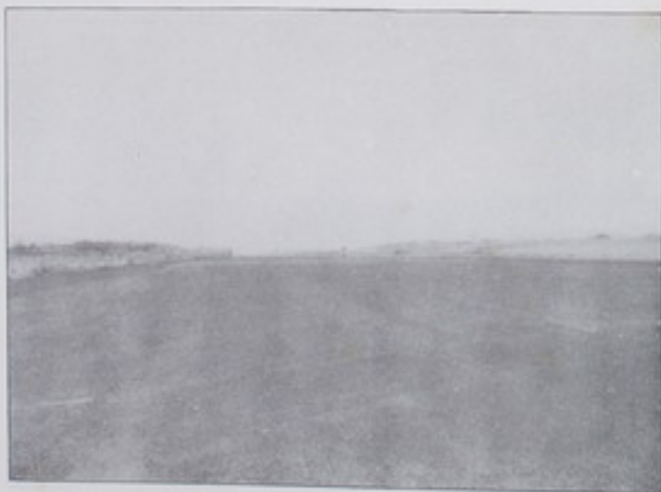
Pista Aeropuerto El Coco. (en construcción)
