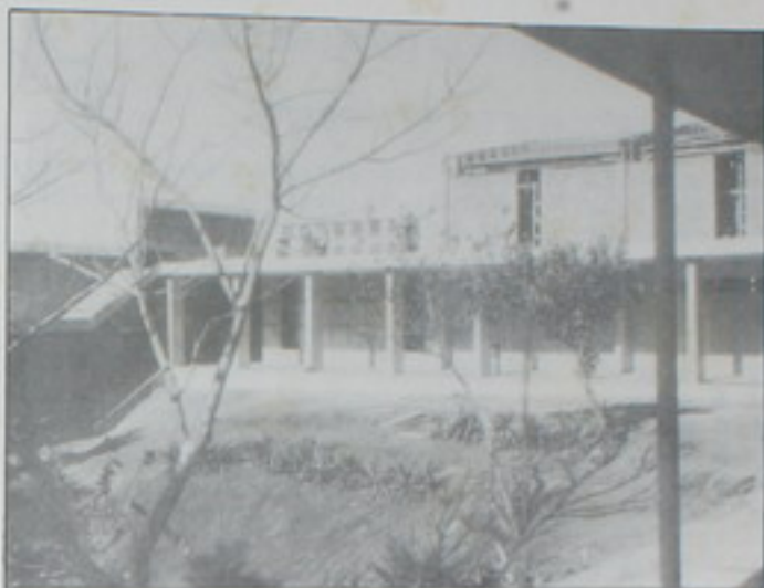
Escuela Normal de Costa Rica - Heredia. (en construcción)
