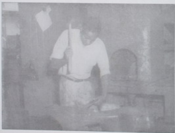
Talleres de mantenimiento.
