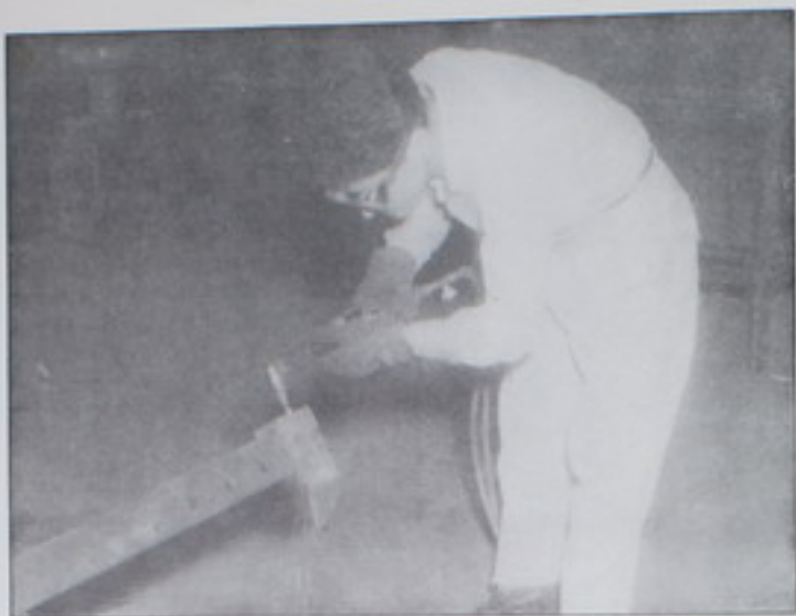
...la soldadura chisporrotea alegremente...
