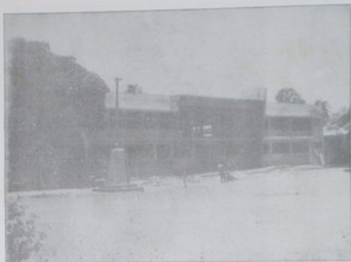
Liceo Martí - Puntarenas. (en construcción)
